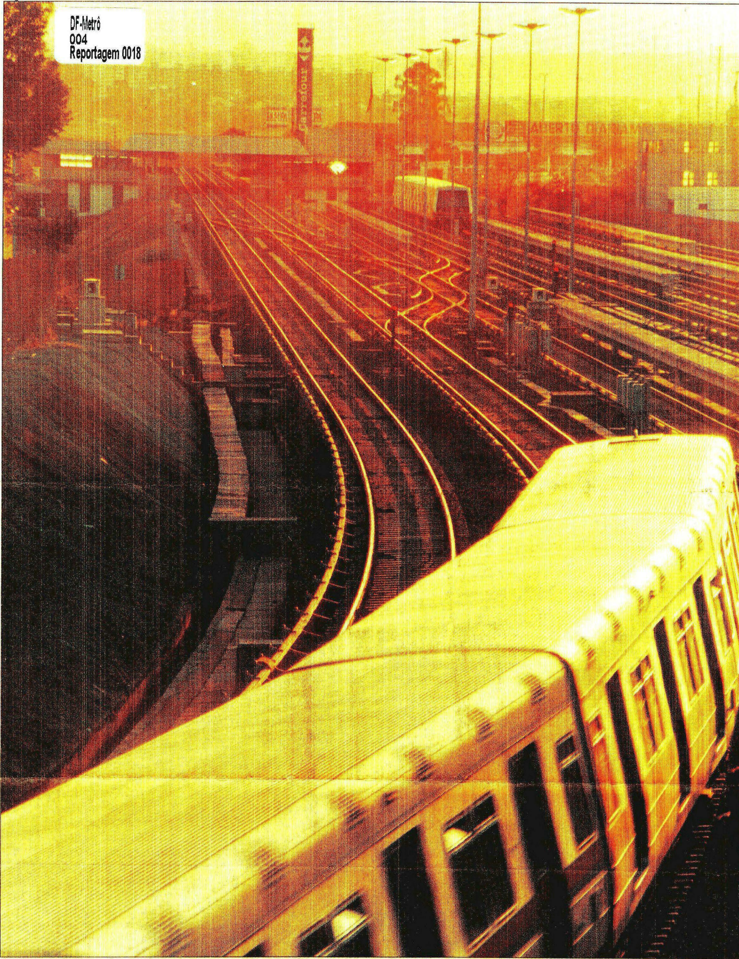
As viagens dos trens do metrô, que levam em média 10 mil passageiros por dia, vão ser interrompidas para voltar quando a obra estiver pronta
