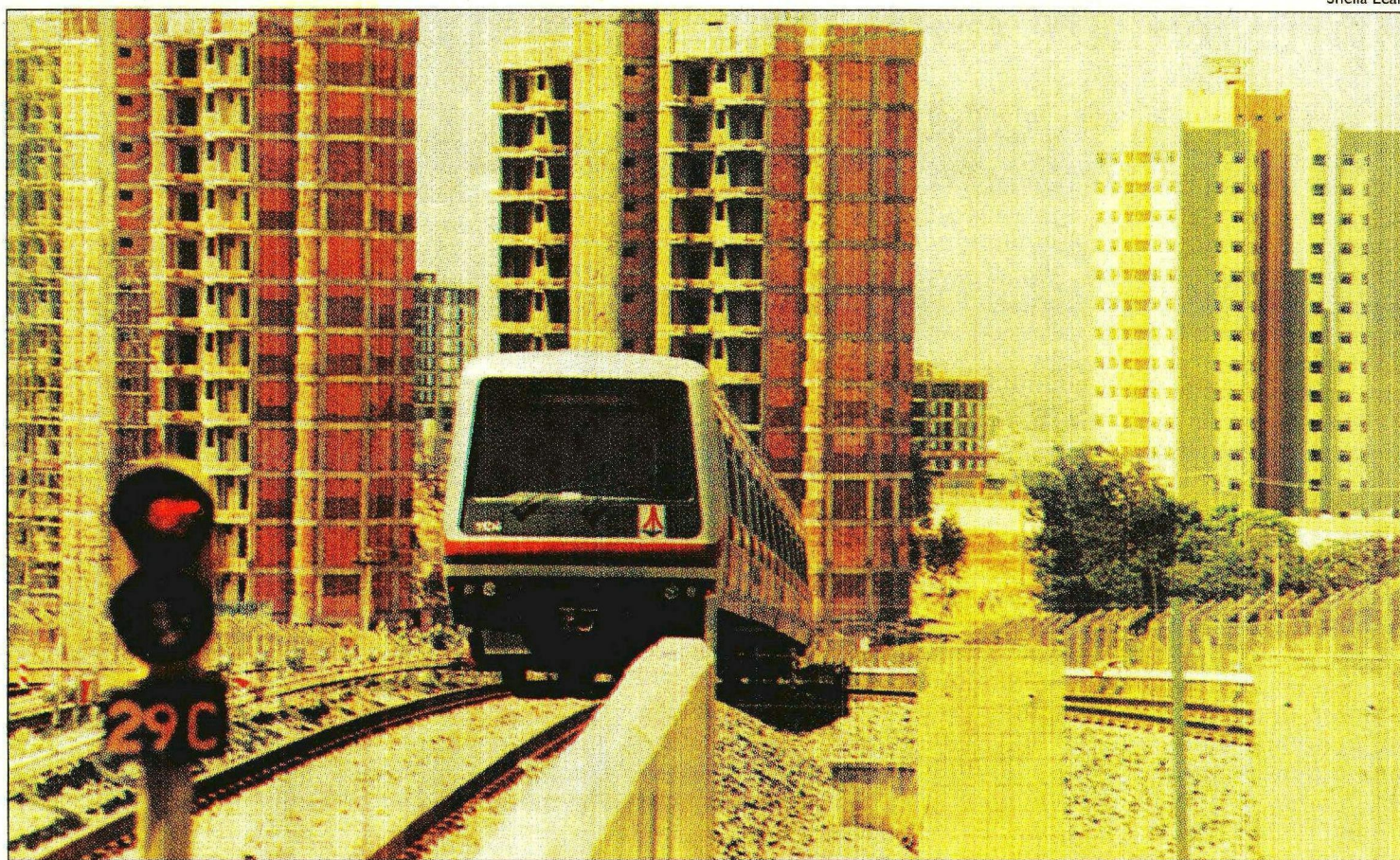
As obras recomçam e em oito meses o trecho principal estará concluído. Ceilândia vai demorar quatro meses mais
