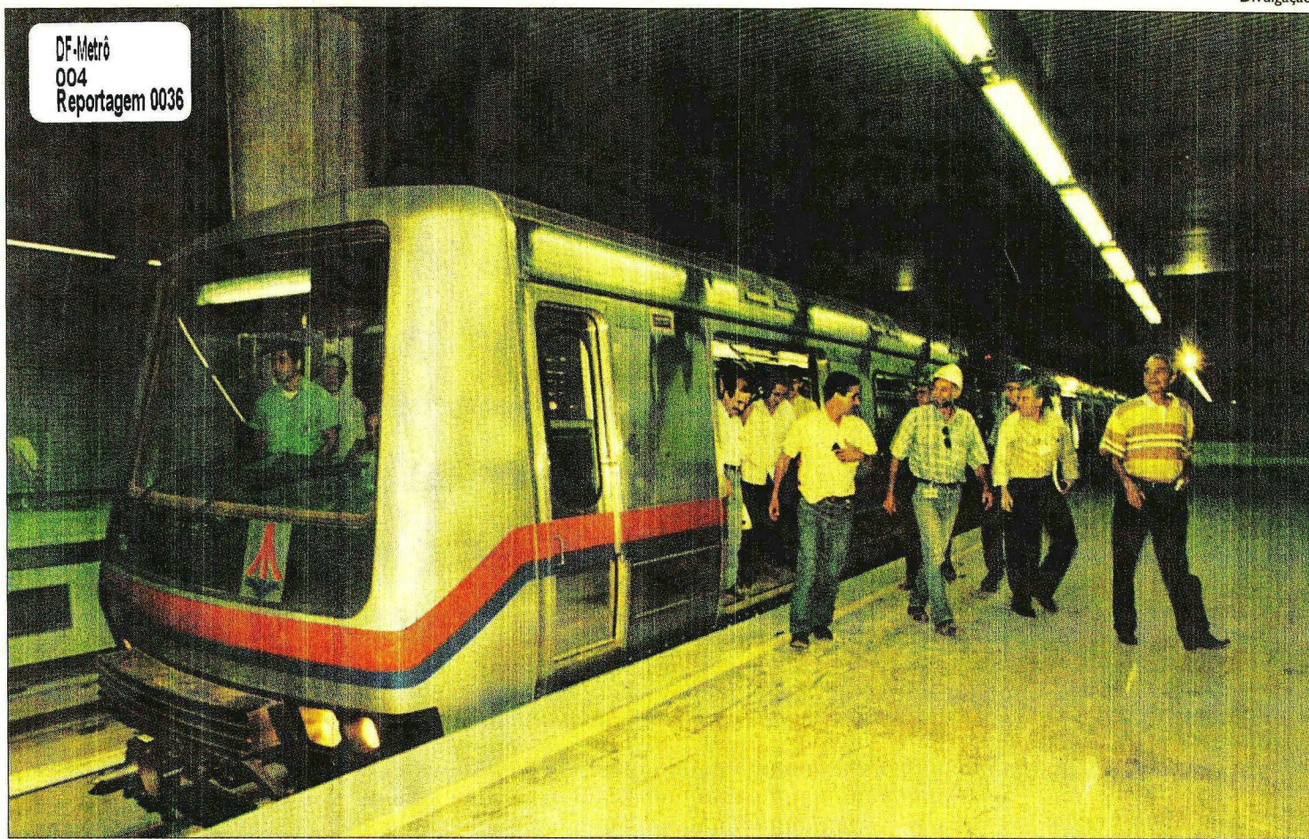
Obras do metrô seguem em frente, segundo informa o secretário de Fazenda, apesar dos cortes ocorridos no orçamento do DF
