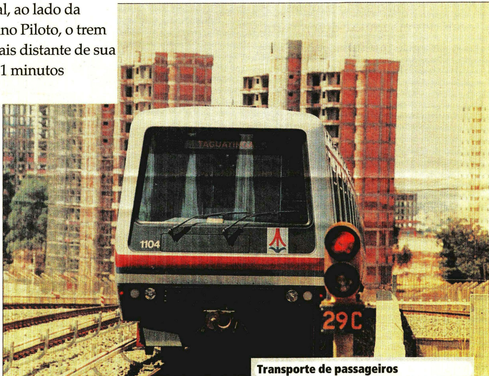
CADA CONJUNTO de trem do metrô transportará o correspondente a 16 ônibus convencionais
