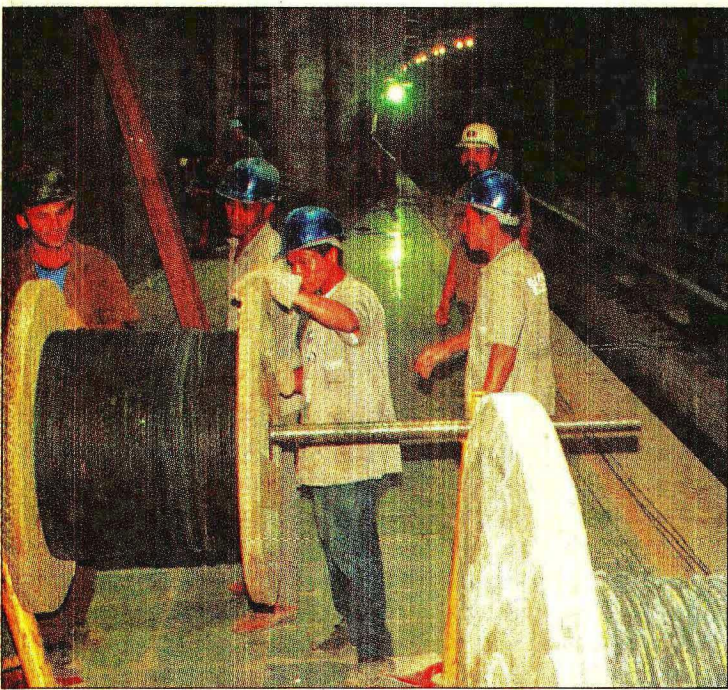
NOS TÚNEIS do Plano, trabalho está entrando na reta final
