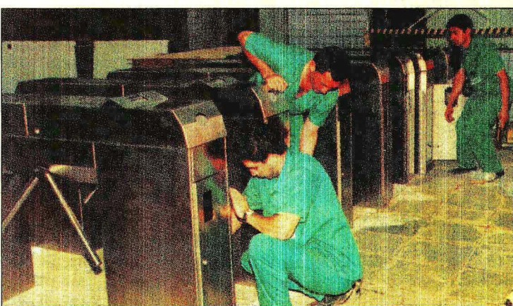
ROLETAS já foram instaladas no trecho que está em teste
