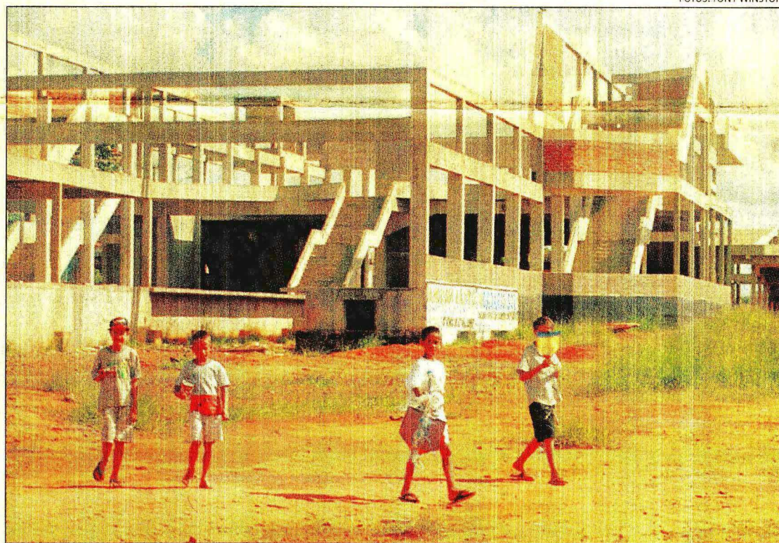
QUANDO ficar pronta, a futura estação de Ceilândia Sul terá grande fluxo de passageiros
