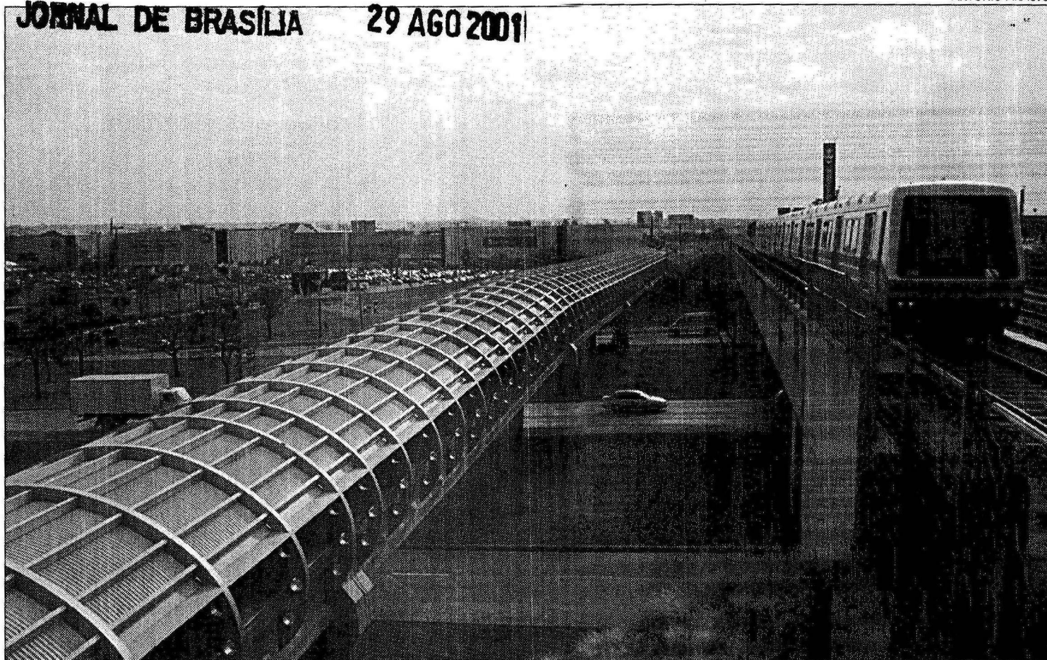
LIBERADA ONTEM , a passarela da Estação do ParkShopping facilita vida dos usuários do metrô que trabalham na região
