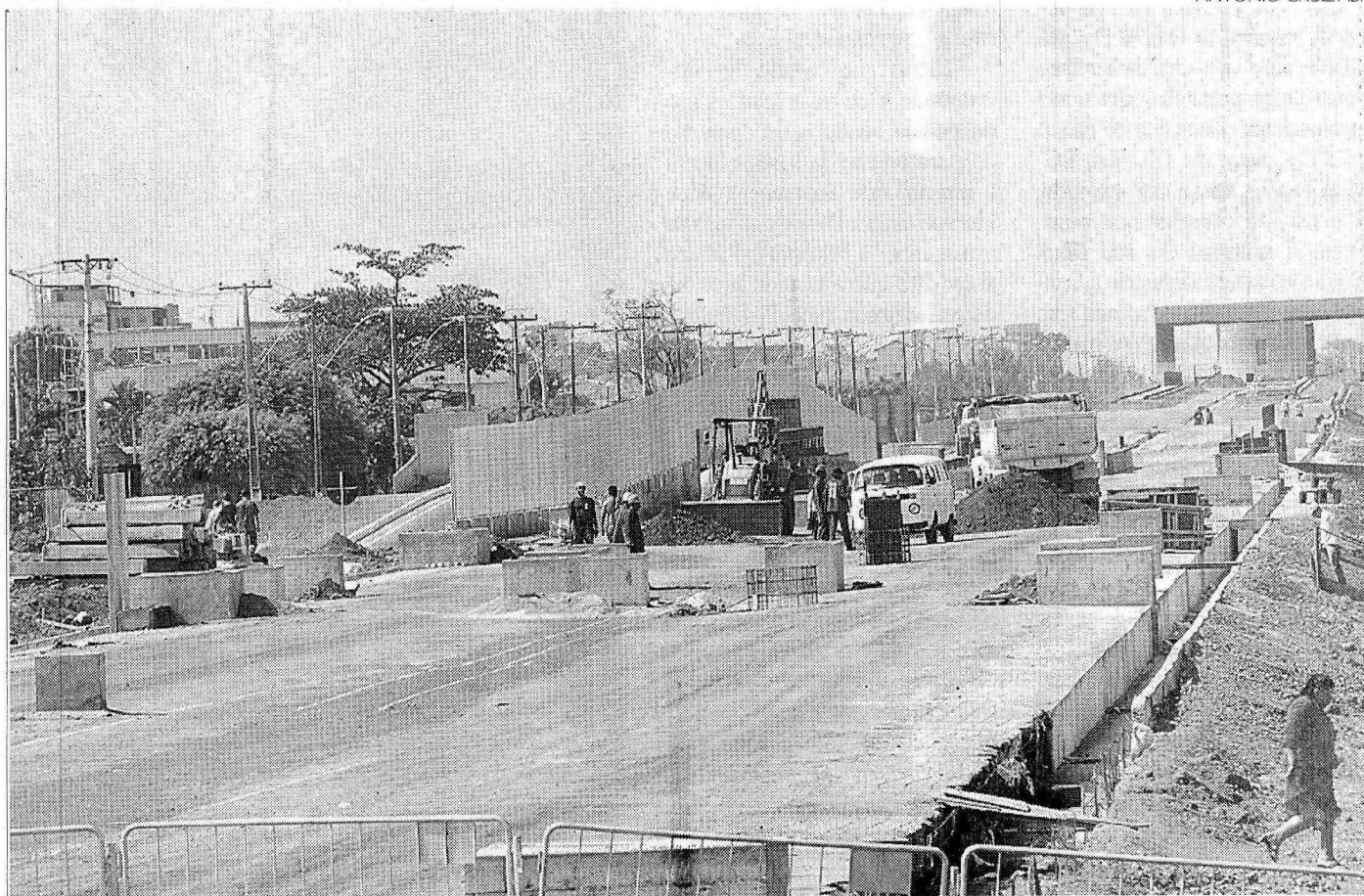
■ OBRA DO METRÔ EM CEILÂNDIA. SEGUNDO O SECRETÁRIO DE TRANSPORTES, O QUILOMETRO DA SUBTERRÂNEO SUPERA R$ 100 MILHÕES
