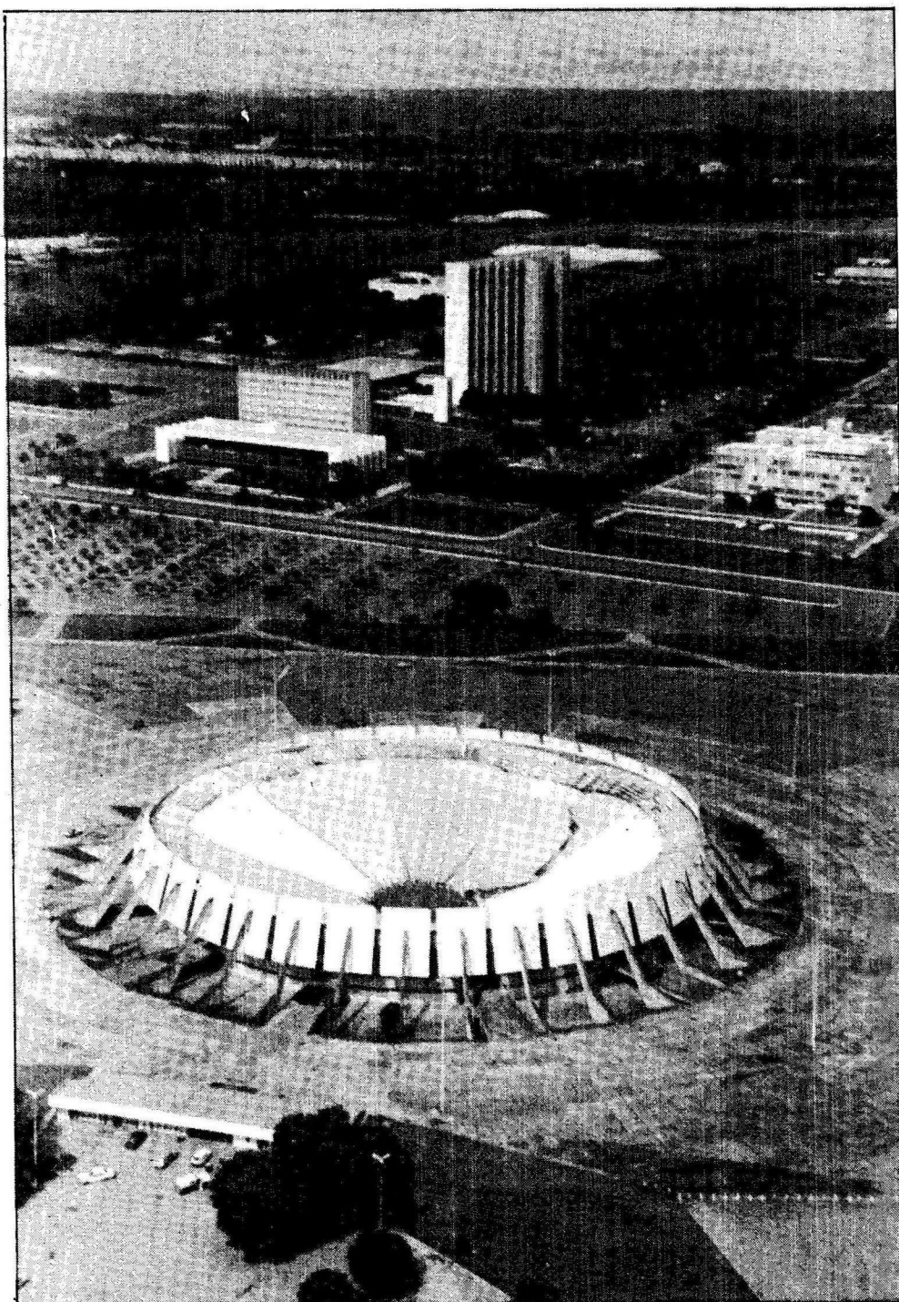
Ginásio: acústica especial e status de ginásio de múltiplas funções
