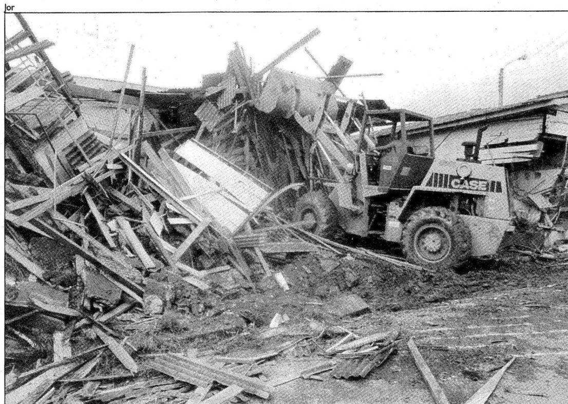
As máquinas derrubaram as paredes de madeira em pouco tempo: ainda havia um hóspede na casa
