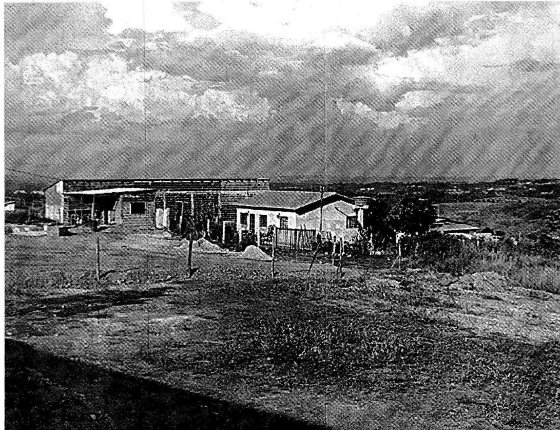
No setor, dividido em terrenos de 800 metros quadrados, estão sendo erguidas outras 132 casas
