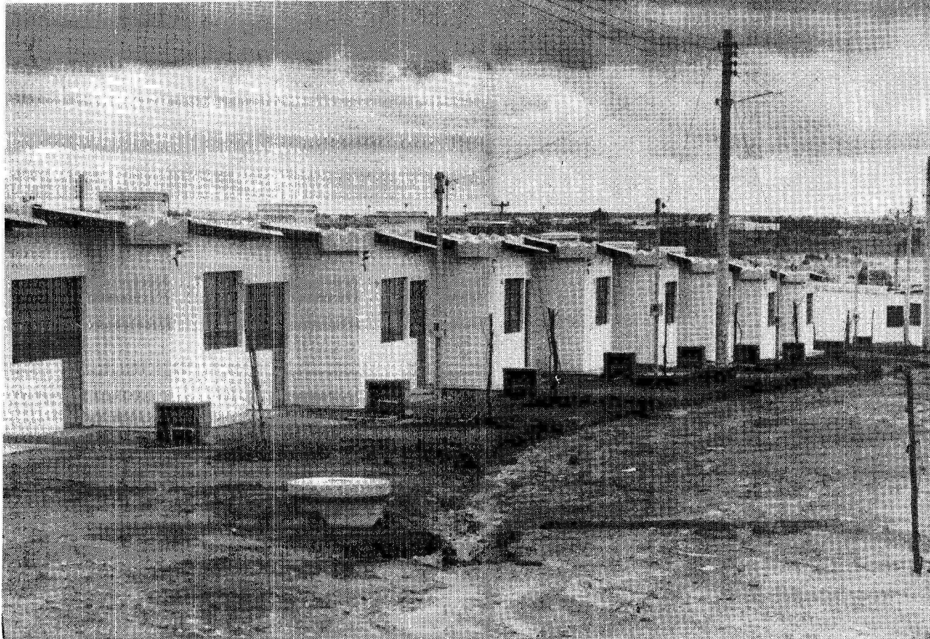
O aspecto bem conservado das casas destoa da falta de infra-estrutura, como a pavimentação
