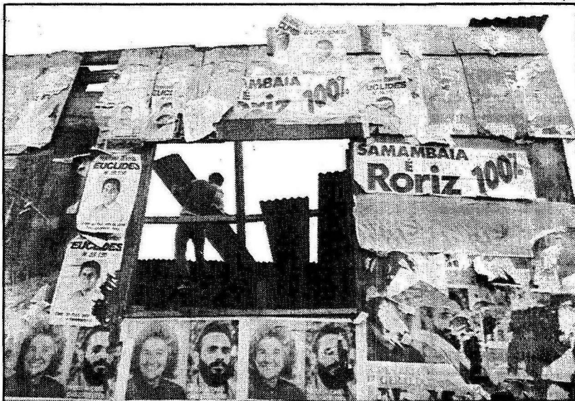
Antônio Soares recoloca as telhas de seu barraco arrancadas pela chuva
