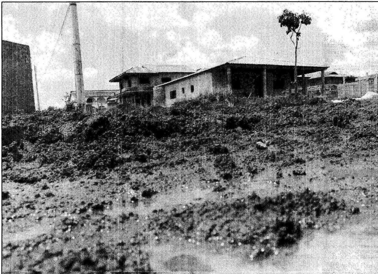
O barro frequente denuncia a falta de uma rede de águas pluviais no Setor de Mansões de Samambaia
