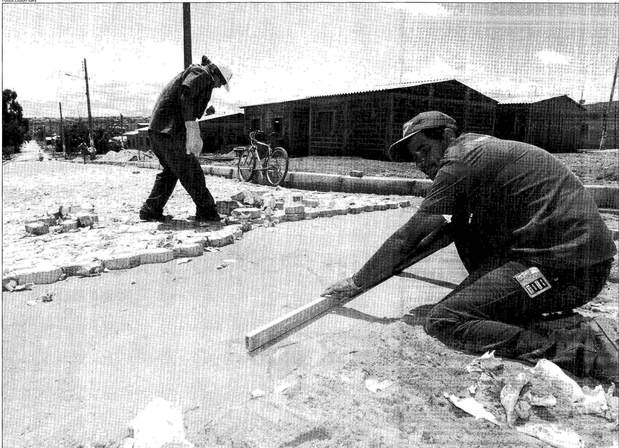
Há oito anos, a quadra 629 da Expansão de Samambaia surgiu do aterramento de um grande buraco: pavimentação com bloquetes de concreto deixou para trás os tempos de lama e lixo
