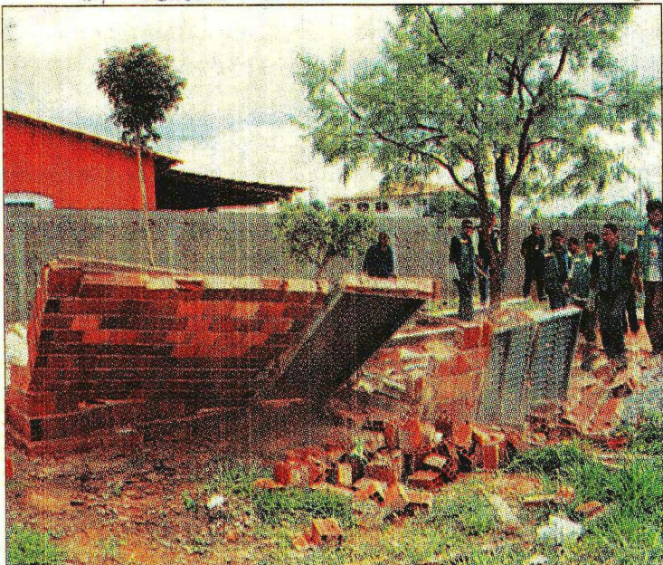
A demolição foi feita por agentes públicos e o deputado Rainha
