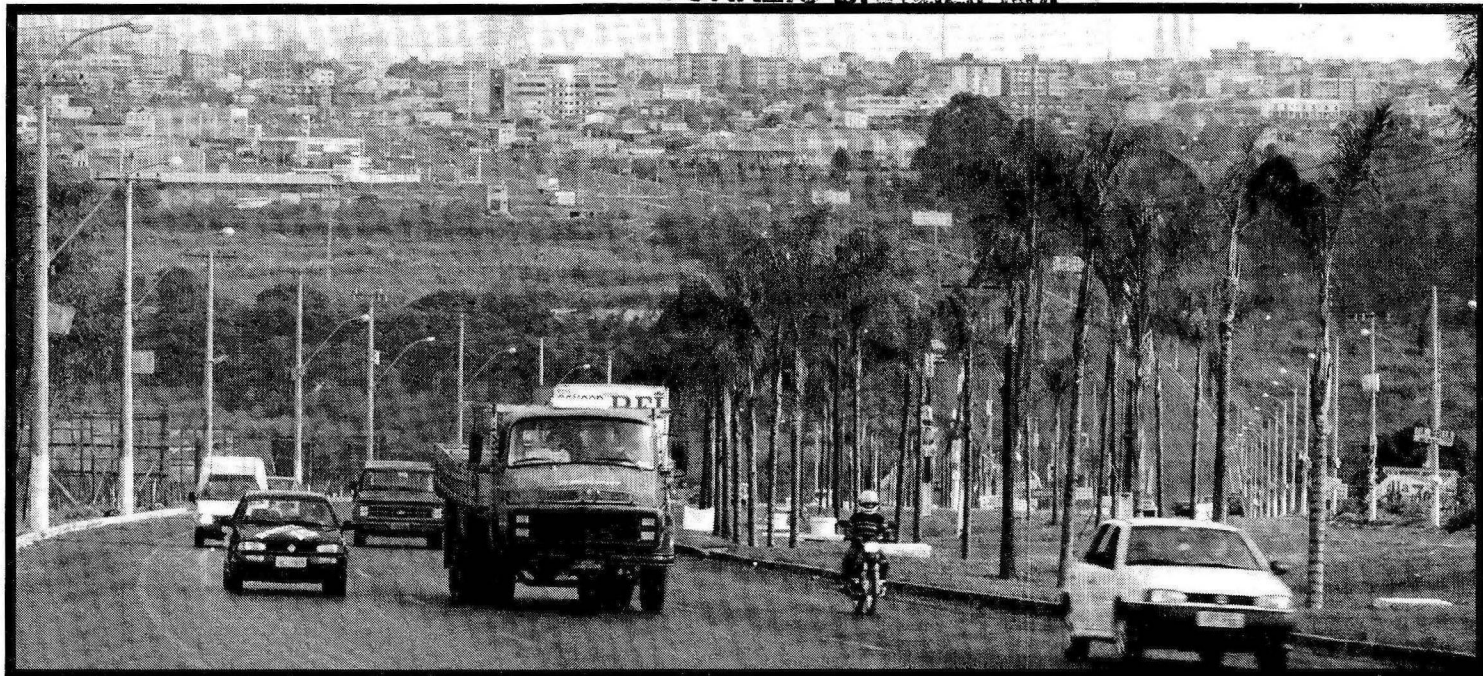
SAMAMBAIA TORNOU-SE UMA REGIÃO ADMINISTRATIVA INDEPENDENTE EM 1989. DESDE ENTÃO, NÃO PÁRA DE CRESCER E EXIGIR MAIS MELHORIAS URBANAS
