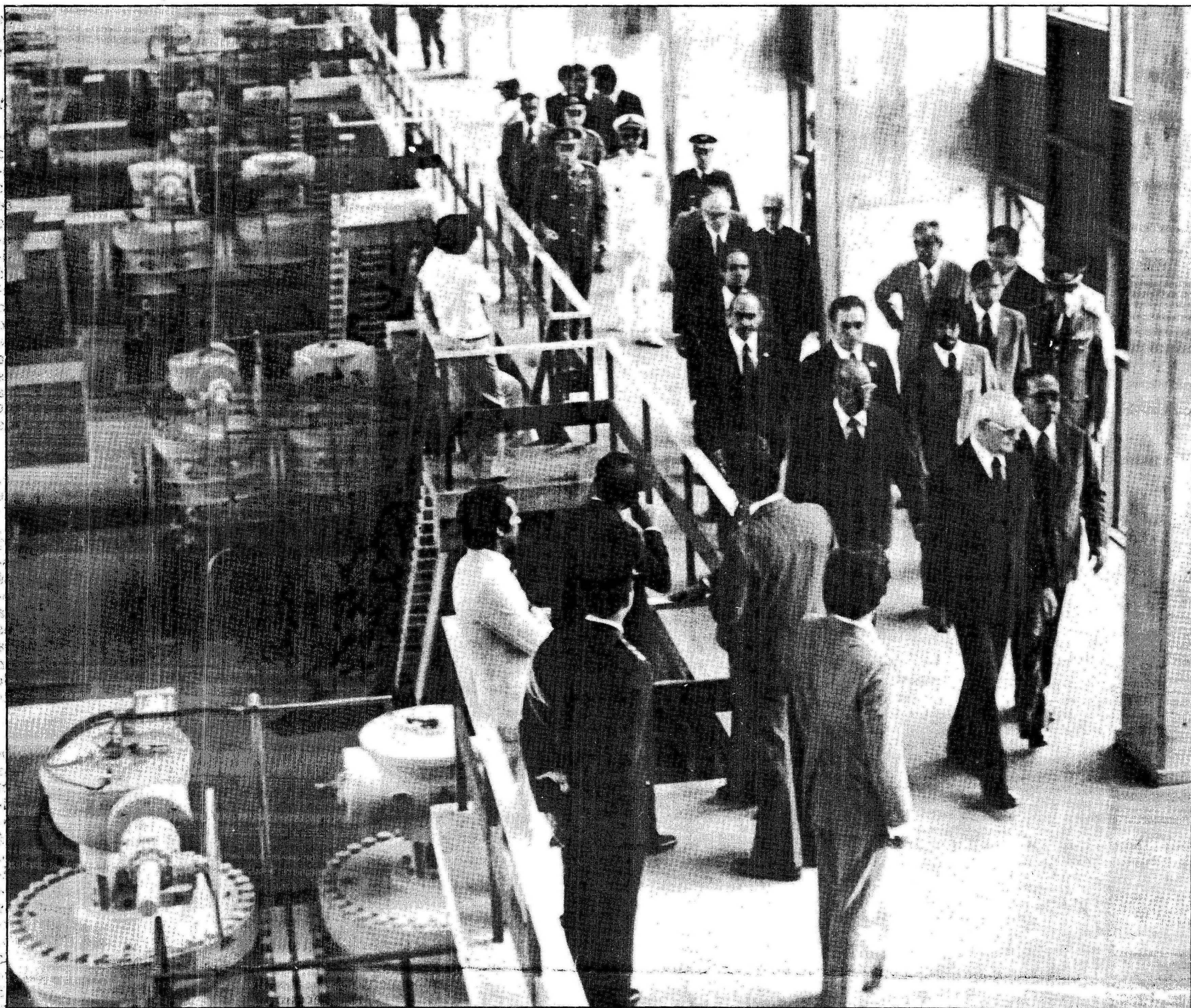
Autoridades e convidados visitam a sala de máquinas
