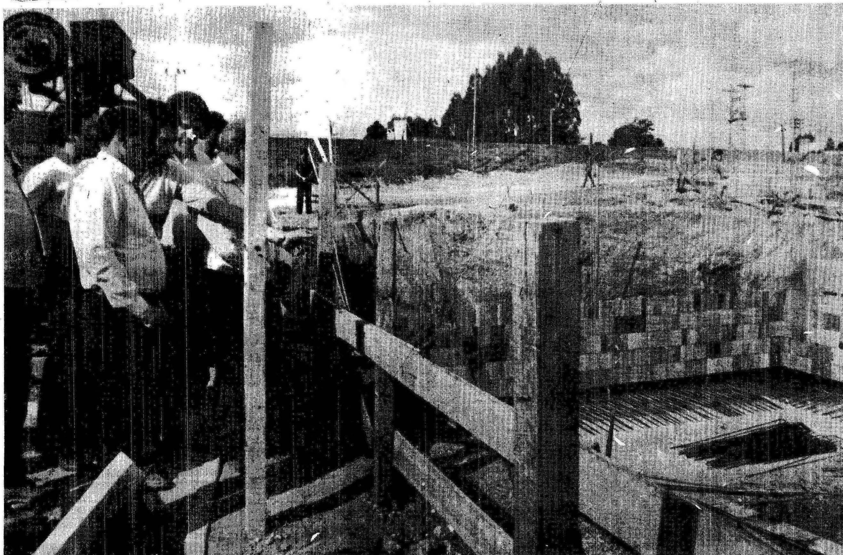
O setor de saneamento básico foi uma das prioridades do governador José Ornellas. Aqui ele visita uma das obras que vai inaugurar
