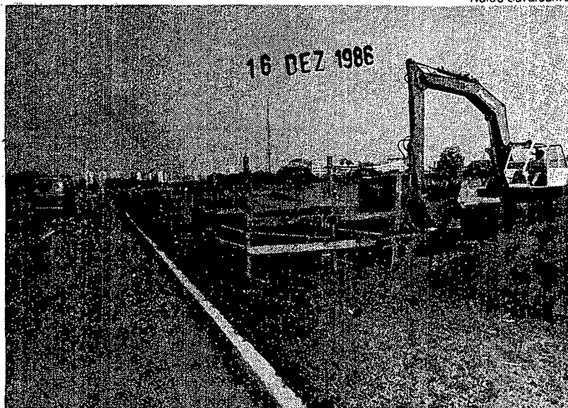
Obra de interligação dos reservatórios deve terminar em março
