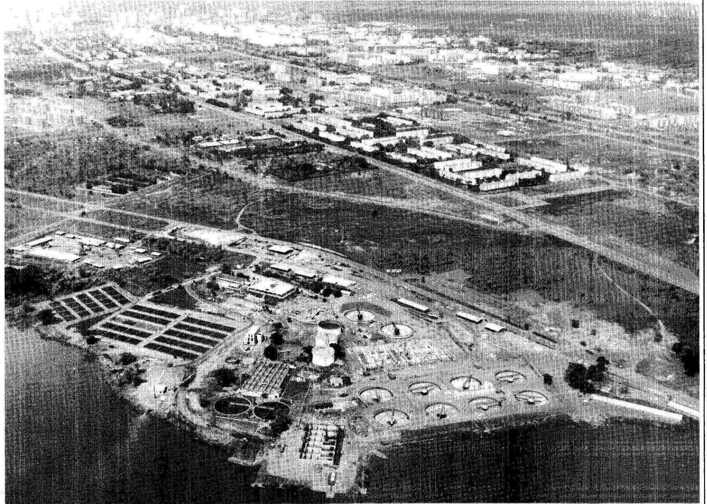
As obras da Estação de Tratamento de Esgotos Norte chegam à fase final de execução
