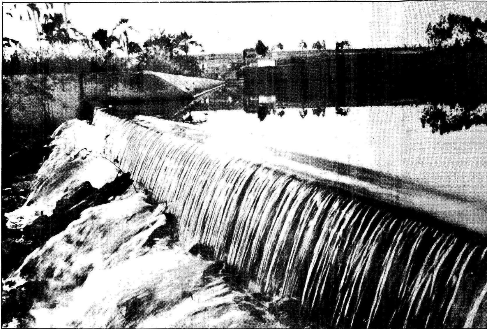
Fechada há sete meses, a barragem de Alagados está sendo poluída pelos fazendeiros
