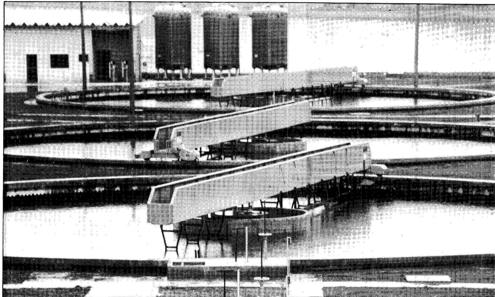
As novas estações de tratamento de esgoto têm tecnologia pioneira na América Latina, com capacidade para atender a um milhão de habitantes
