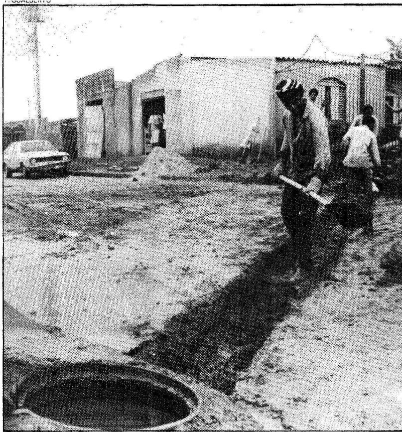
A obra vai beneficiar nove mil pessoas e custou Cr$ 270 milhões
