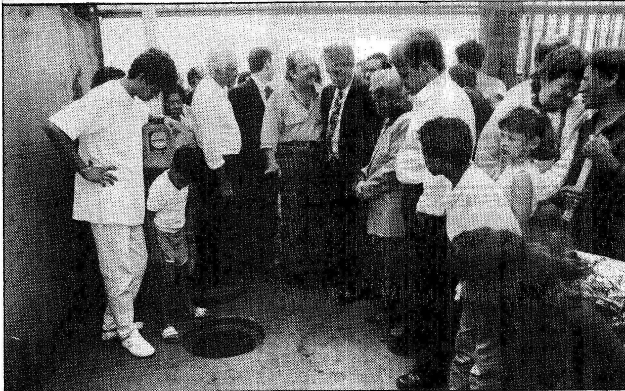
Durante a inauguração do esgoto condominial Roriz inspecionou parte desse sistema que é pioneiro no DF
