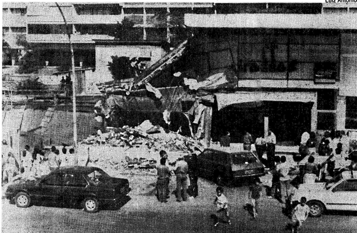
O deslizamento de um pilar que segurava a marquise foi o que provocou a destruição da lanchonete Giraffas
