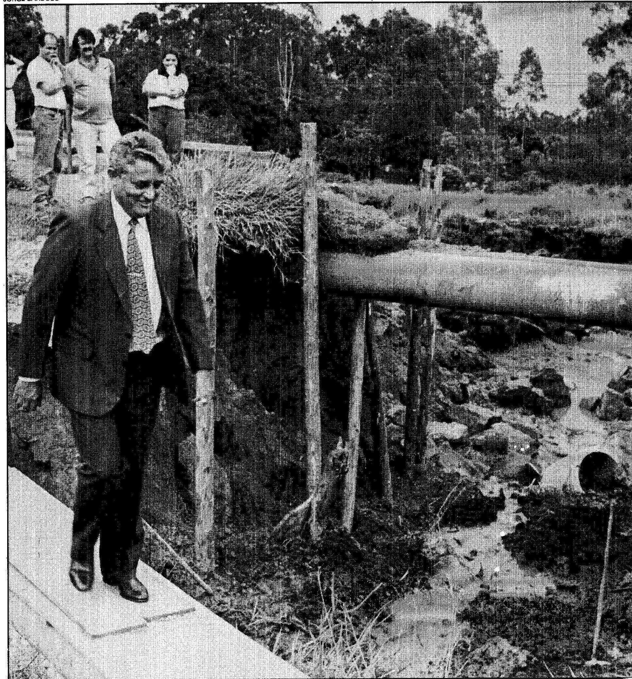
Roriz visita obras do sistema de esgoto em Samambaia, que terá 60 km de rede e vai beneficiar 23 mil pessoas
