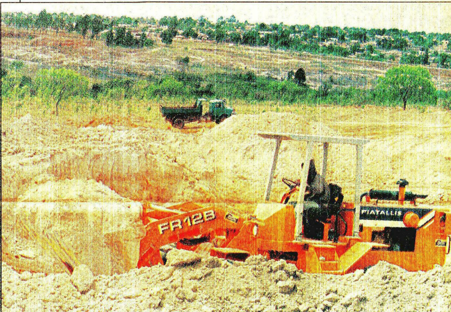
Escavadeiras retiram areia para edificações em Sta. Maria
