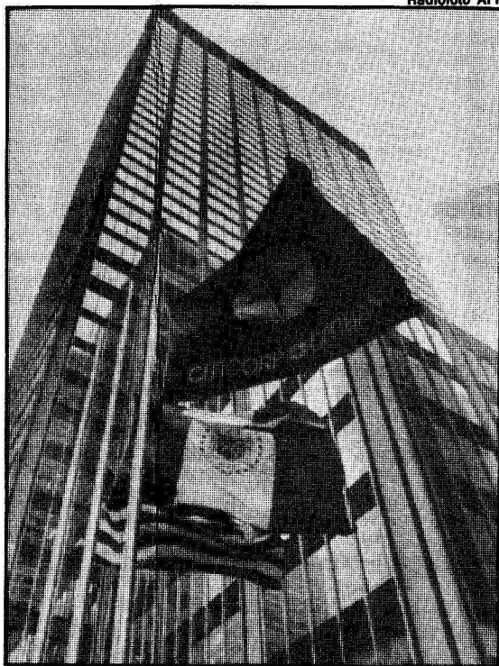
Edifício-sede do Citicorp e Citibank em Nova York
