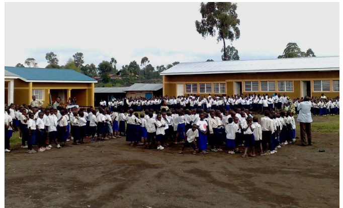
Nuevos edificios de la escuela pública de Biayi, RDC, construidos por UNOPS para un proyecto del Banco Mundial
