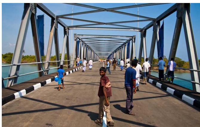
Puente de Irrakandi en Sri Lanka, rehabilitado con fondos del Gobierno español y con UNOPS como agencia ejecutora
