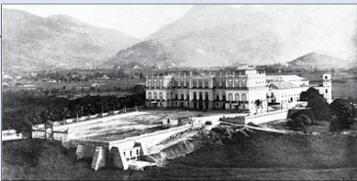
Paço de São Cristóvão, em 1862. Em 2018, prédio foi varrido pelo fogo
