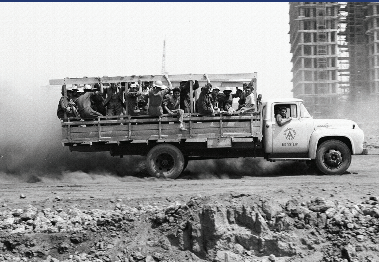
Construção de Brasília.
