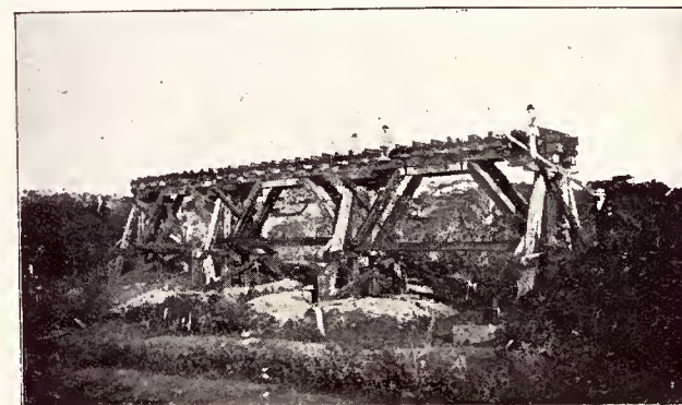
Rio Anhandohy — Ponte em construção
