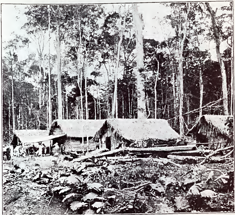
Matta virgem, bastante limpa, no Norte do Estado. Acampamento para a construção da E. de F. Madeira—Mamoré
