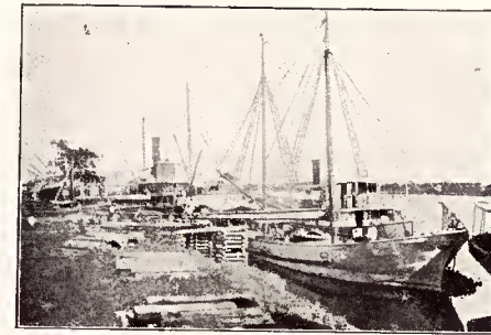
Porto Esperança, Descarga de material
