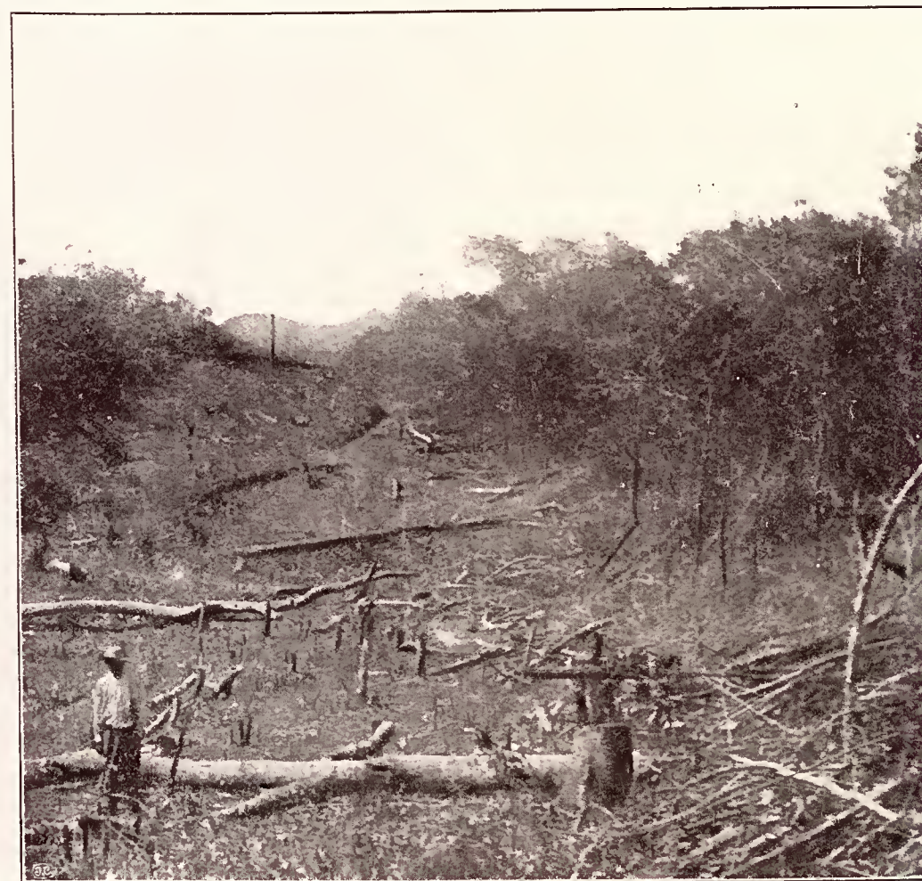
Floresta destruida (Picada para construção da linha telegr.) no rio S. Lourenço
