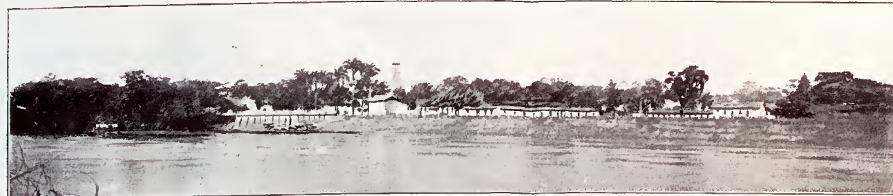
Vista geral e Porto da Usina da Conceição
