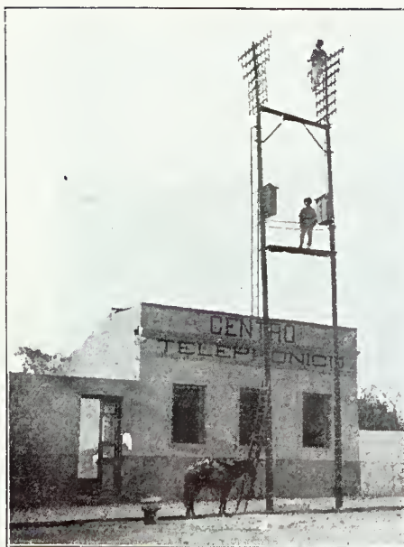
Corumbá, Estação Central Telephonica
