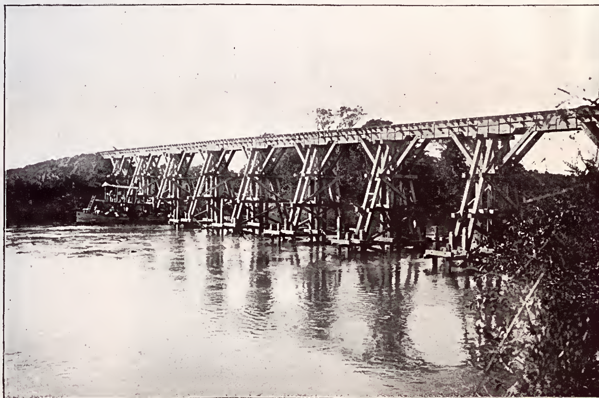
N. O. B: Saloba — Ponte provisória sobre o rio Miranda
