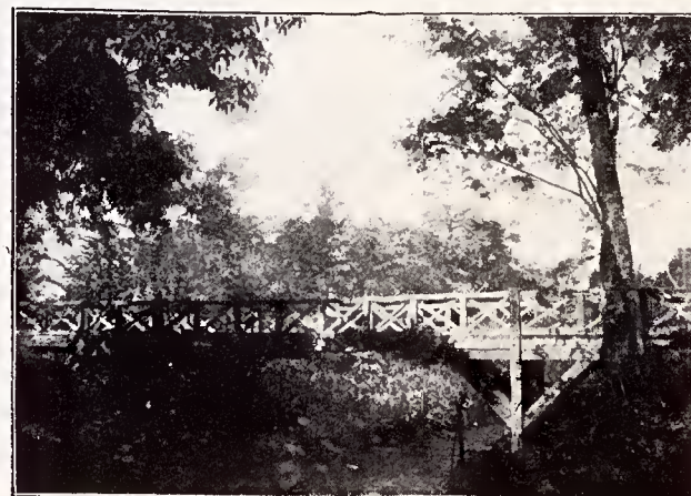
Nioac, Ponte sobre o rio Urumbeba
