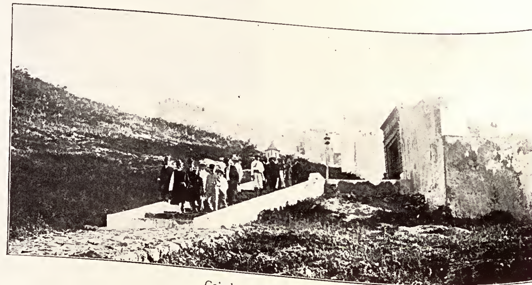
Coimbra, Entrada ao Forte
