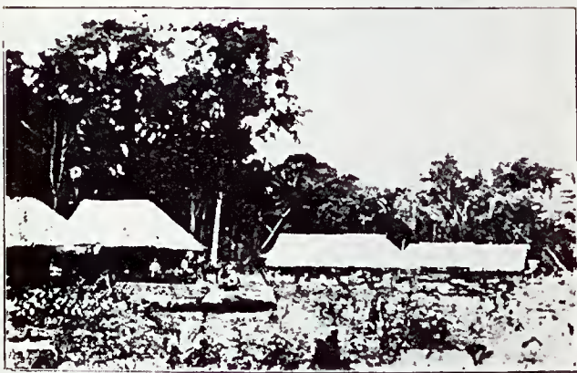
Acampamento no matto durante a construção
