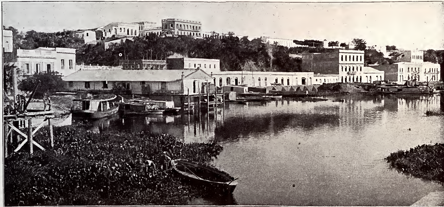
Corumbá, Vista parcial
