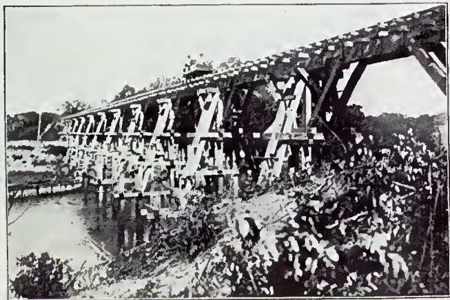
N. O. B: Km. 223. Ponte provisoria sobre o rio Aquidauana
