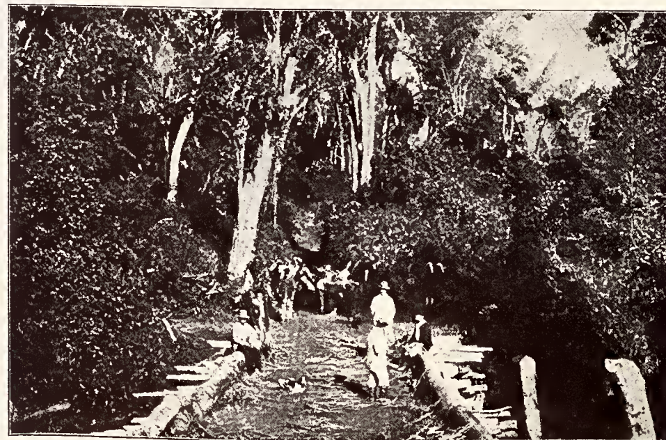
Ponte sobre o arroio Tacuara
