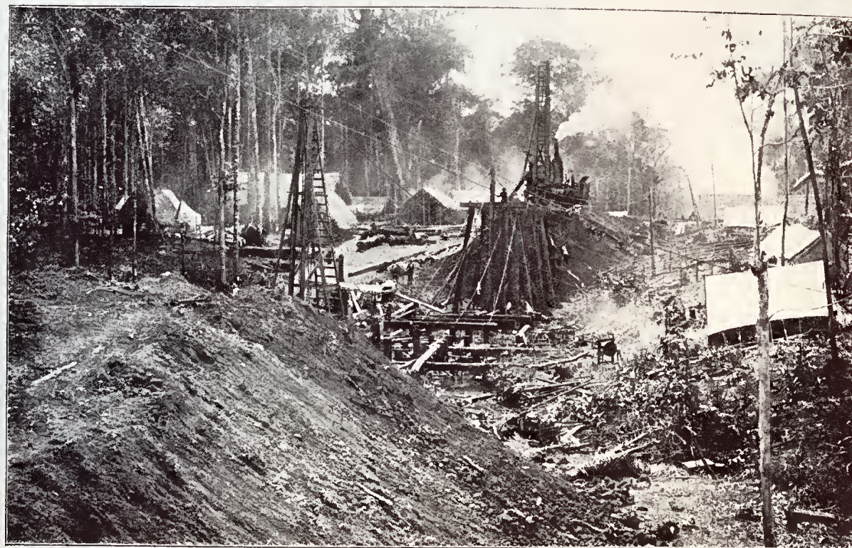
Construindo uma ponte
