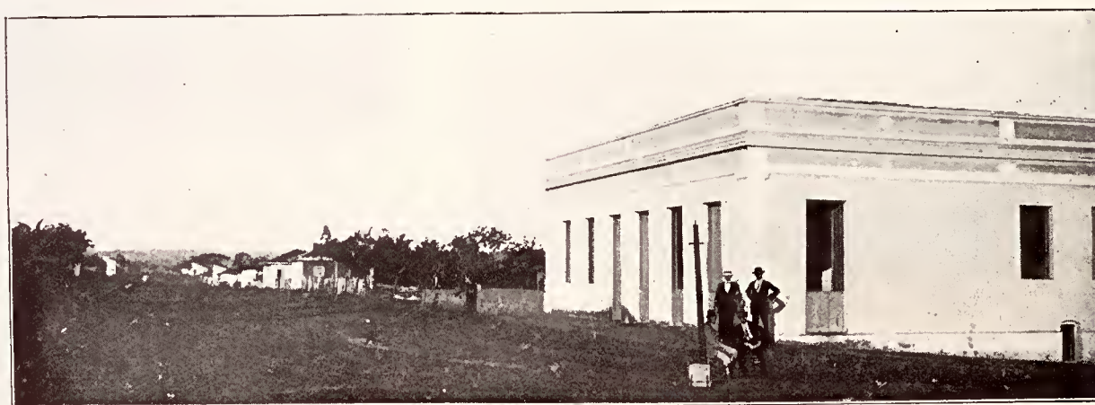
Campo Grande, Novas construções
