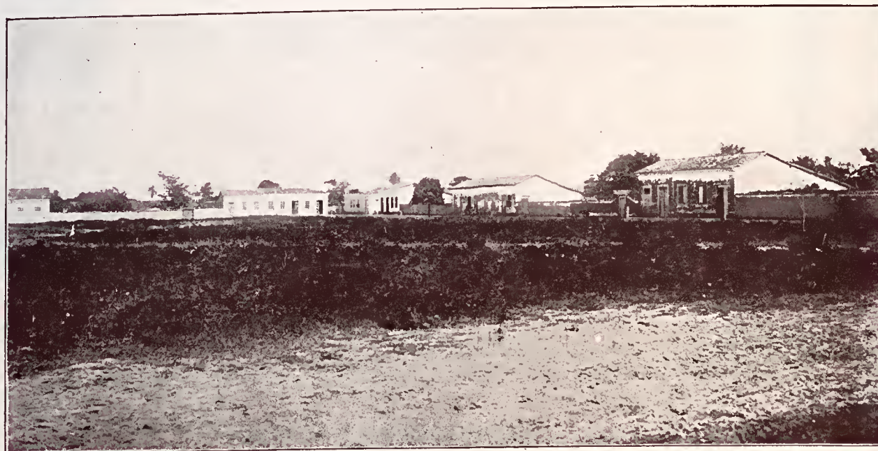
São Luiz de Cáceres, Praça Dique de Caxias
