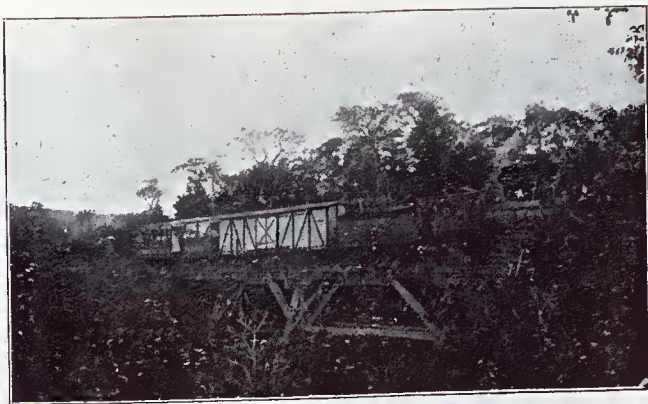
N. O. B: Ponte provisória — Ribeirão «Morcego»
