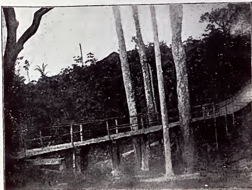
Rio Machado — Ponte na estrada de rodagem entre as cachoeiras
