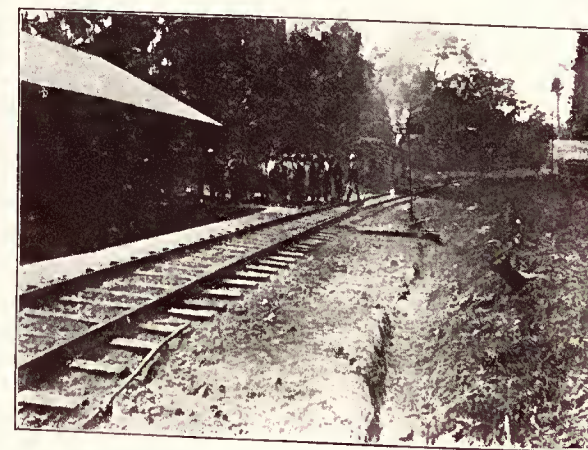
E. F. Madeira—Mamoré: Estação Km. 133
