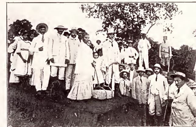
Coxipó-Assú: Pedra fundamental da Ponte
