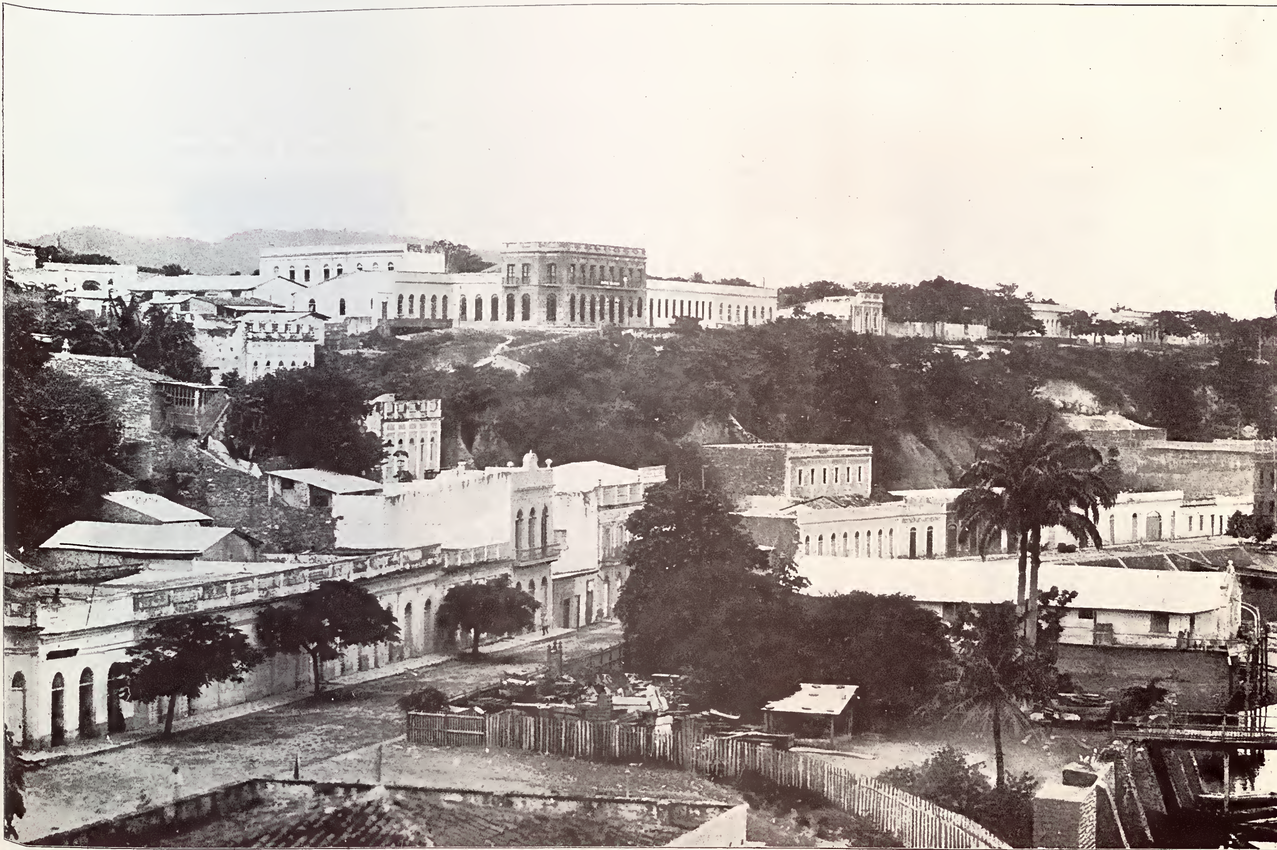
Corumbá, Vista parcial
