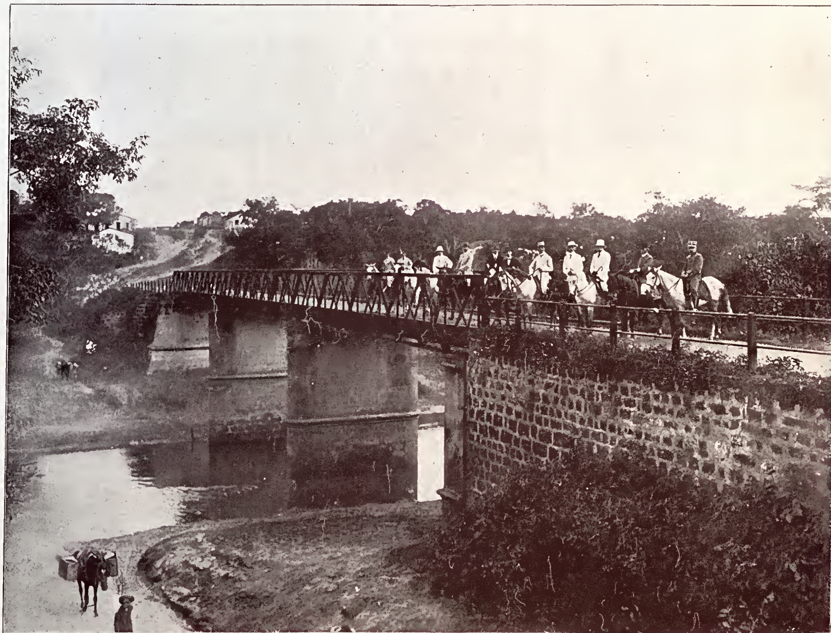
Coxipó: A Ponte metallica
