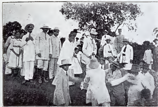
Coxipó-Assú: Pedra fundamental da Ponte
