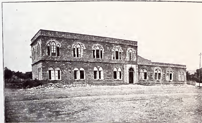
Corumbá, Collegio Sta. Thereza, em Construção
