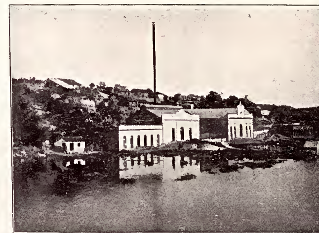
Corumbá, Usina Electrica
