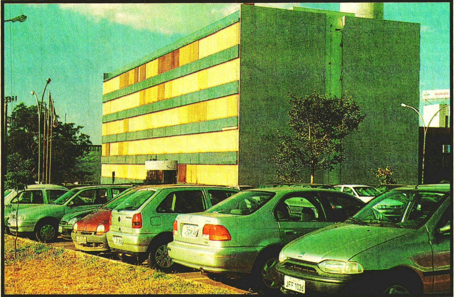
COM A APROVAÇÃO DO PROJETO DE AUTORIA DE LÚCIA CARVALHO, O ESTACIONAMENTO DO TRT PODERÁ SER CERCADO: INTERVENÇÃO NO ESPAÇO PÚBLICO
