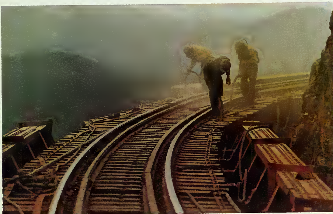
Recuperação de viaduto na Serra do Mar - Corredor do Paraná
