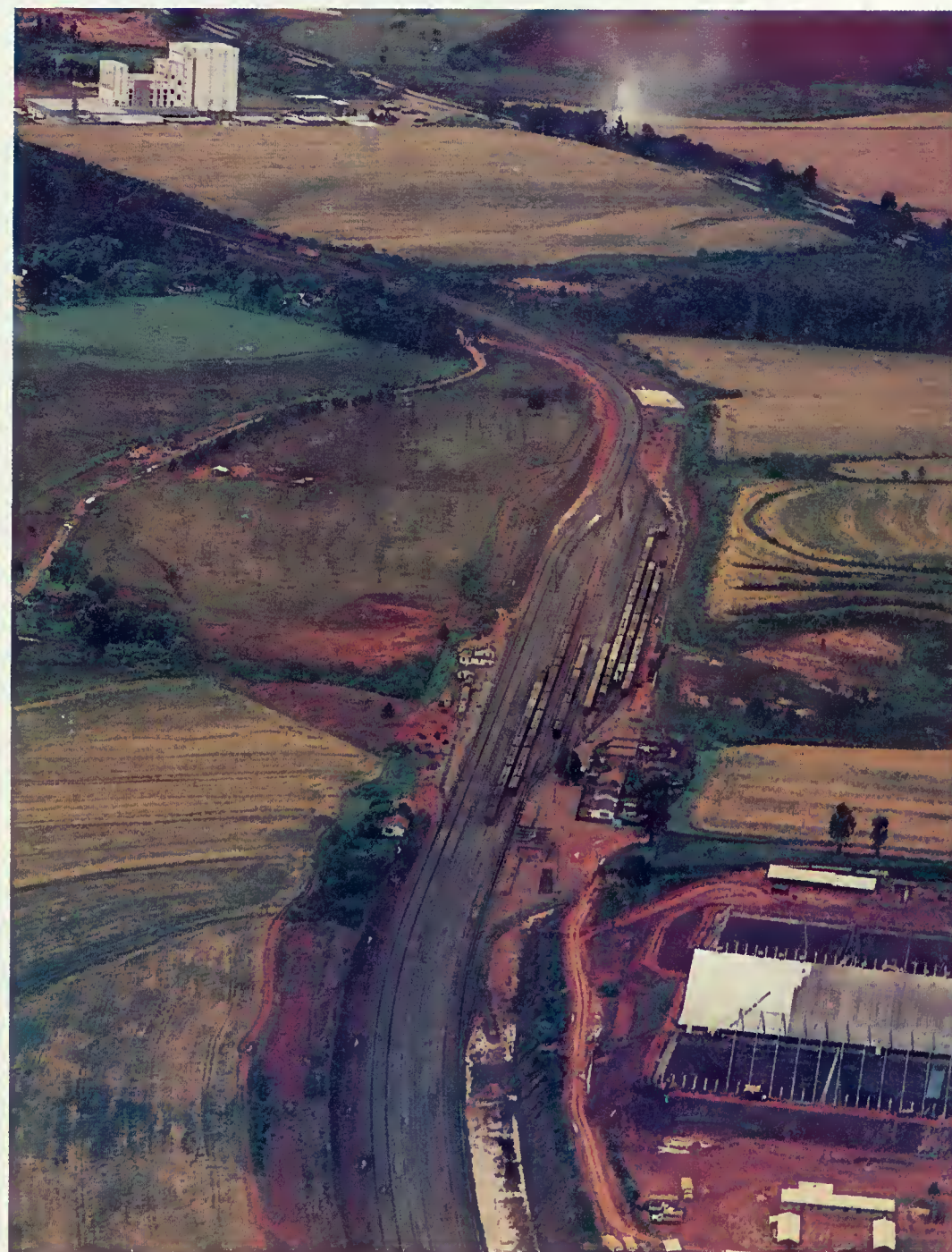
Trecho da Variante Desvio Ribas - Tibagi Ponta Grossa-PR
