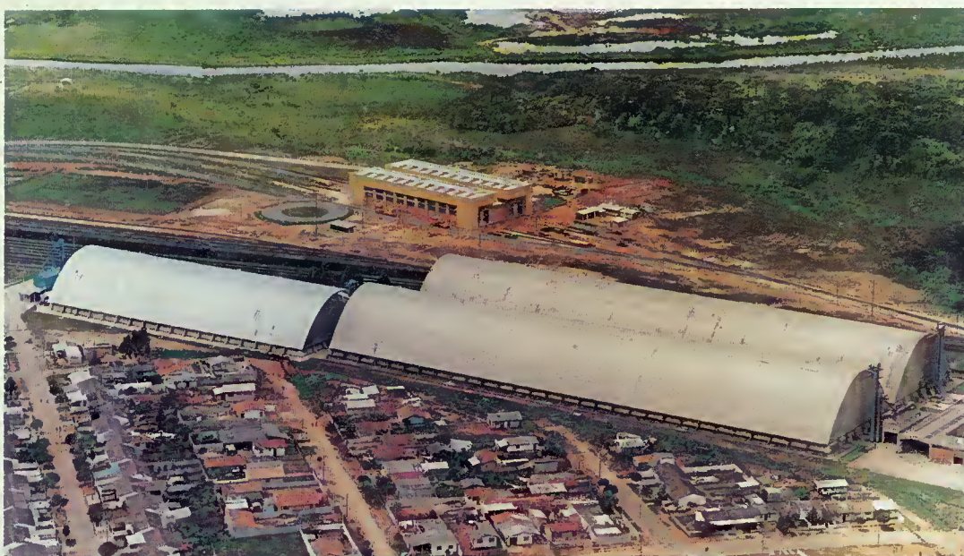
Armazém da AGEF no pátio de Iguaçu em Curitiba-PR
