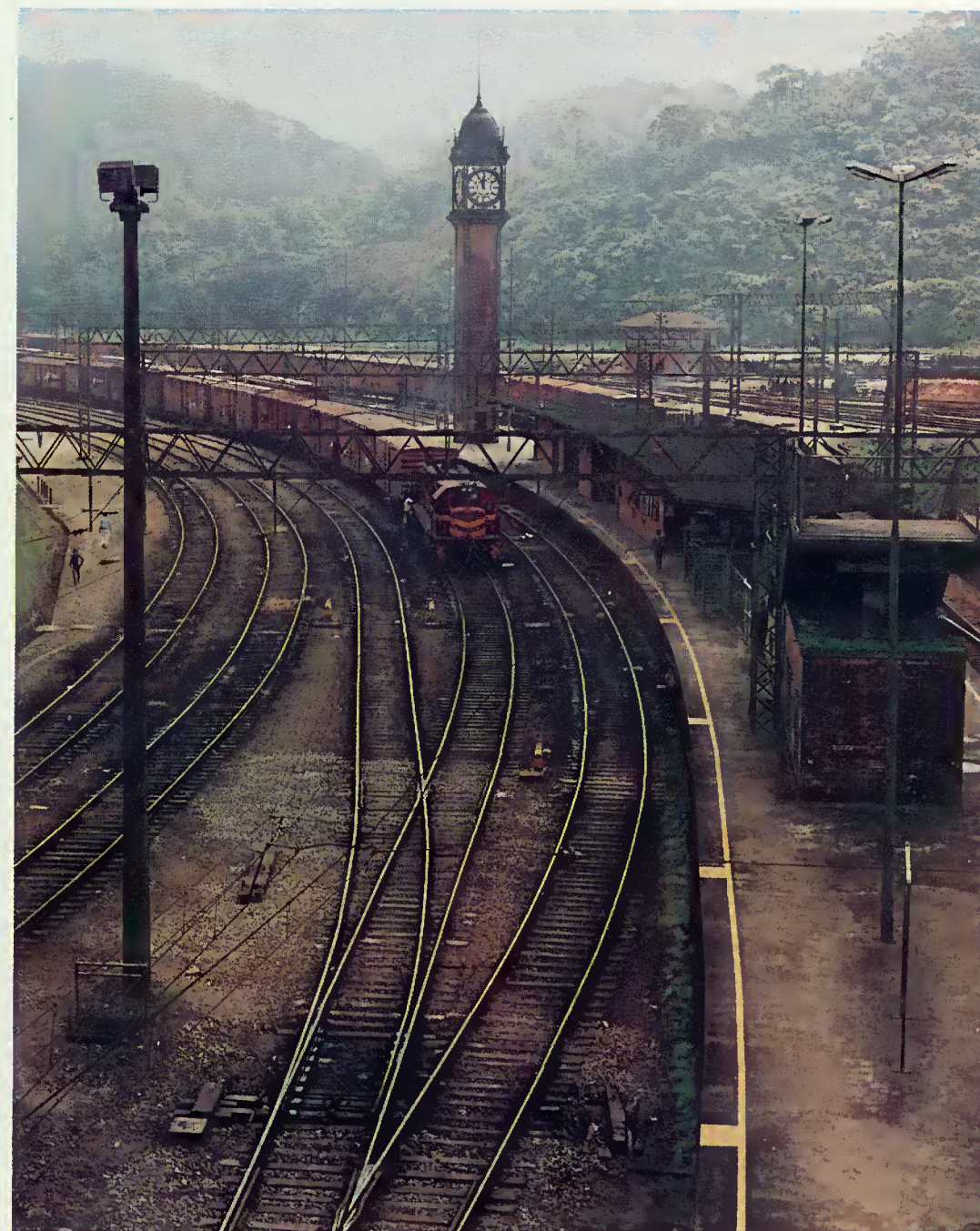
Estação e pátio de Paranapiacaba - SP
