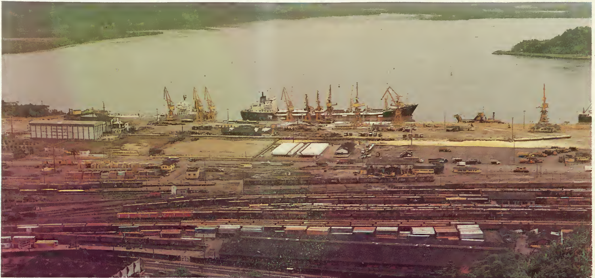
Pátio ferroviário no Porto de Santos - SP
