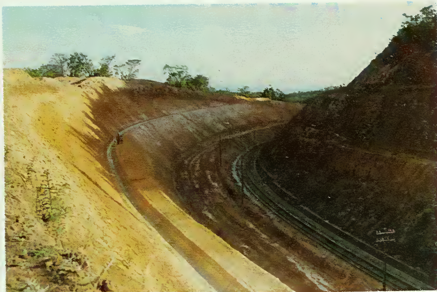
Alargamento de corte no corredor - Goiás - Minas Gerais
