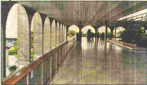
ITAMARATY: VÃO DE 36M SEM PILASTRAS DE SUSTENTAÇÃO
