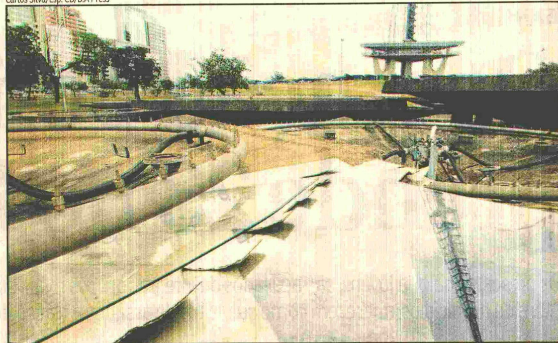
Construída em 1965, a fonte luminosa deve ficar pronta para os 50 anos da capital, em abril de 2010
