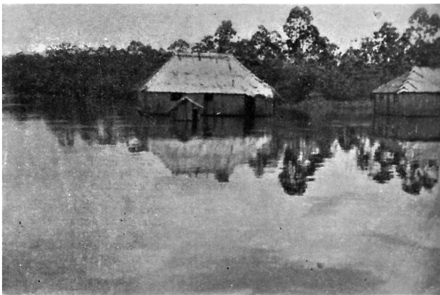
Figs. 172 e 173 – Casas palafíticas do rio Jari, construídas de tábuas verticais justapostas e cobertas de folhas de palmeira. Vê-se o tipo de cobertura em quatro faces. Estas fotos foram tomadas por ocasião de uma inundação em 1950 (época normal). (Foto do autor.)
