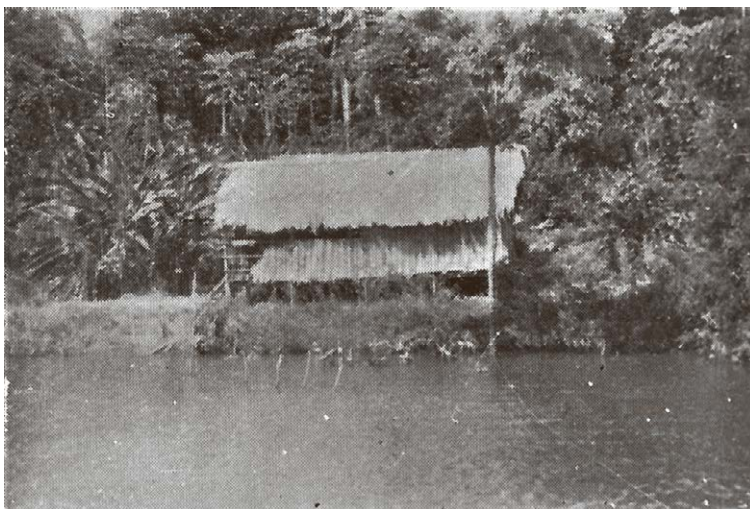
Fig. 164 – Casa de seringueiro no baixo curso do rio Jari, vendo-se a floresta ao redor. Na construção dessa habitação o material utilizado compõe-se de lascas grosseiras de palmeira colocadas verticalmente umas ao lado das outras, sendo a cobertura feita também com folhas de palmeira. (Foto do autor.)
