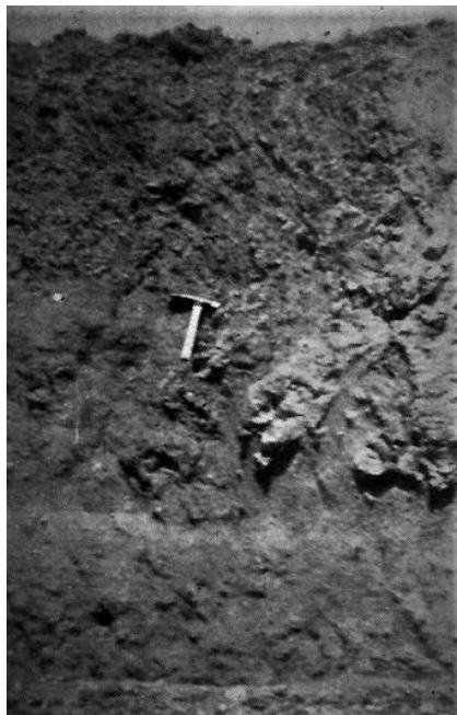
Fig. 113 – Nesta foto, vemos um corte de barranco da entrada entre Porto Grande e Ferreira Gomes, junto ao igarapé do Palha, onde se observa uma camada de piçarra — concreções ferruginosas — cuja espessura é superior a 1 metro vindo logo abaixo uma camada de material areno-argiloso de coloração vermelha. A edificação parece ter-se realizado num material aluvial resultante de uma possível transgressão marinha no quaternário antigo. O grau de laterização desse horizonte superior do solo impossibilita no momento qualquer tentativa agropecuária, nessa zona. (Foto do autor.)
