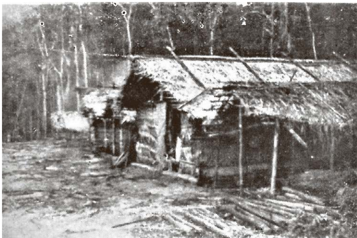
Fig. 153 – As casas da colônia de Matapi no Acampamento do Ferro são muito rudimentares e atestam o seu aspecto de construções temporárias. (Foto do autor.)
