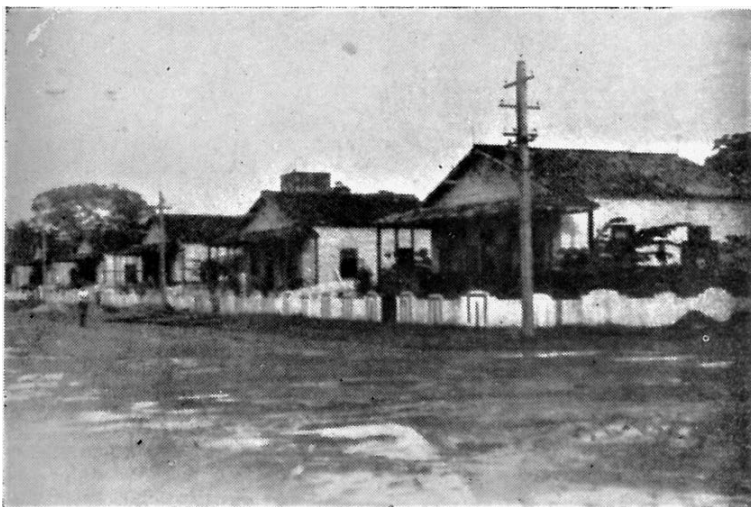
Fig. 157 – Casas de madeira, forradas, assoalhadas e construídas sobre pequenas estacas na cidade de Macapá. Este tipo de habitação é geralmente construído para chefes de serviços administrativos do território. (Foto do autor.)
