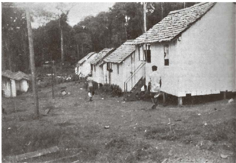
Fig. 162 – Casas construídas pela companhia Icomi, que está explorando atualmente o manganês da serra do Navio, no rio Amapari. Essas casas são construídas sobre pequenas estacas para evitar a umidade do solo e não a possibilidade de enchente do rio Amapari, uma vez que estão a cerca de 8 a 10 metros acima do leito do rio. O material usado na construção das paredes — tábuas — foi transportado de Macapá a Porto Platon numa distância de 110 quilômetros em caminhão e daí rio acima numa distância de 100 quilômetros em embarcações. A cobertura é de “cavacos”. (Foto do autor.)
