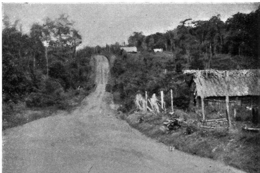
Fig. 147 – Zona devastada ao longo da estrada que vai para o campo de aviação na altura do igarapé da Patauazinho, vendo-se alguns lotes de colonos. (Foto do autor.)
