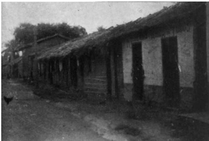
Fig. 181 – Casas de pau a pique cobertas de folhas de palmeira açai na cidade de Macapá. Parte antiga da velha Macapá atrás de catedral. (Foto do autor.)
