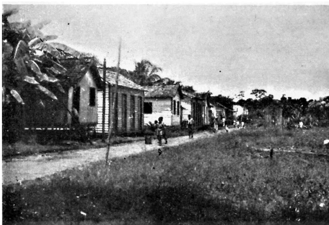
Fig. 175 – Casas de madeira sobre pequenas estacas cobertas de cavacos na vila de Calçoene. (Foto do autor.)
