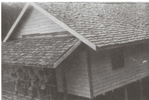
Fig. 163 – Casa de madeira coberta com “cavacos”, na serra do Navio. Uma pequena cobertura como esta consome grande número de “cavacos” (cerca de 7000). A madeira utilizada para se fazer “cavaco” é geralmente a maçaranduba por causa de sua durabilidade. (Foto do autor.)
