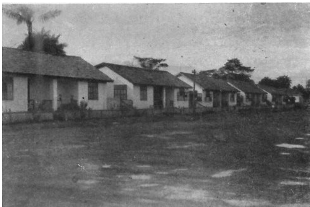
Fig. 180 – Construção de novos bairros residenciais ao norte da velha cidade de Macapá. Observe-se que as casas são de alvenaria e padronizadas. (Foto do autor.)
