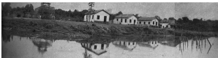
Fig. 27 – Falésia da vila de Boca do Jari, constituída de canga cavernosa, com declive em direção de jusante. (Foto do autor.)
