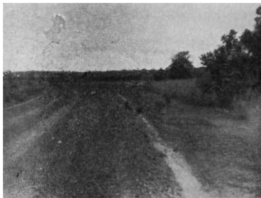
Fig. 236 – Aspecto da rodovia Macapá-Clevelândia, cujo leito é inteiramente coberto de “piçarra”. (Foto do autor.)
