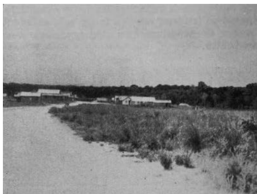
Fig. 237 – Aspecto da rodovia Macapá-Clevelândia, próximo a Porto Grande. (Foto do autor.)
