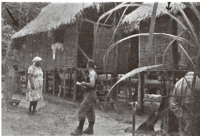
Fig. 170 – Casa construída de “goletas” (varas de bambu) cobertas de folhas de palmeira. A cozinha é ligada à casa por um estrado (seta I). Todas estas casas de crioulos guianos são muito limpas e é frequente possuírem até instalações de um pequenino banheiro (seta II). Povoados de William, no rio Amapari. (Foto do autor.)
