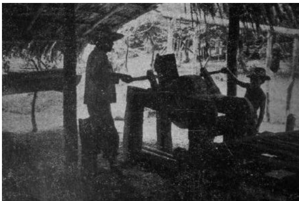
Fig. 234 – Roda para ralar a mandioca. (Foto do autor.)
