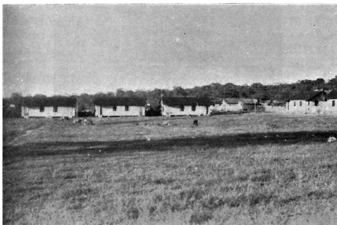
Fig. 145 – A sede da antiga colônia de Clevelândia se acha num terraço de 63 metros, cuja superfície é muito regular, como se observa na foto acima. As casas são todas construídas de madeira e cobertas de telhas do tipo francês. (Foto do autor.)
