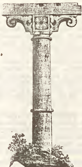
Coluna de madeira no interior da Igreja de São Luiz — 1855.
