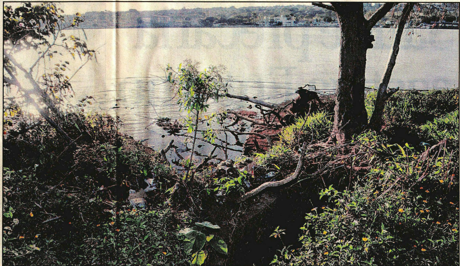
Manilha de esgoto entre o Pontão do Lago Sul e a QL 10: efluentes despejados diretamente nas águas do Lago Paranoá
