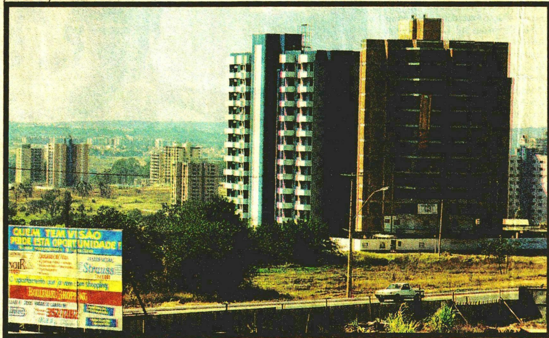
O BAIRRO PRECISA DE SEGURANÇA, ILUMINAÇÃO PÚBLICA, ASFALTO, REDE DE ESGOTO E ÁGUAS PLUVIAIS
