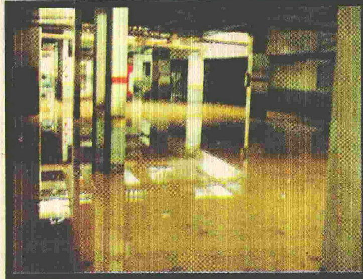
GARAGENS DE PRÉDIOS DA 402 NORTE FORAM INUNDADAS NOVAMENTE
