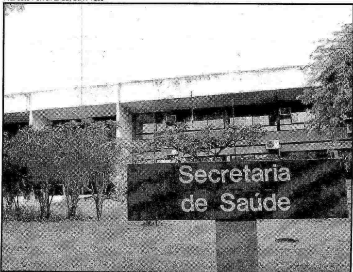
Na Secretaria de Saúde, forros caíram com a água: interdição
