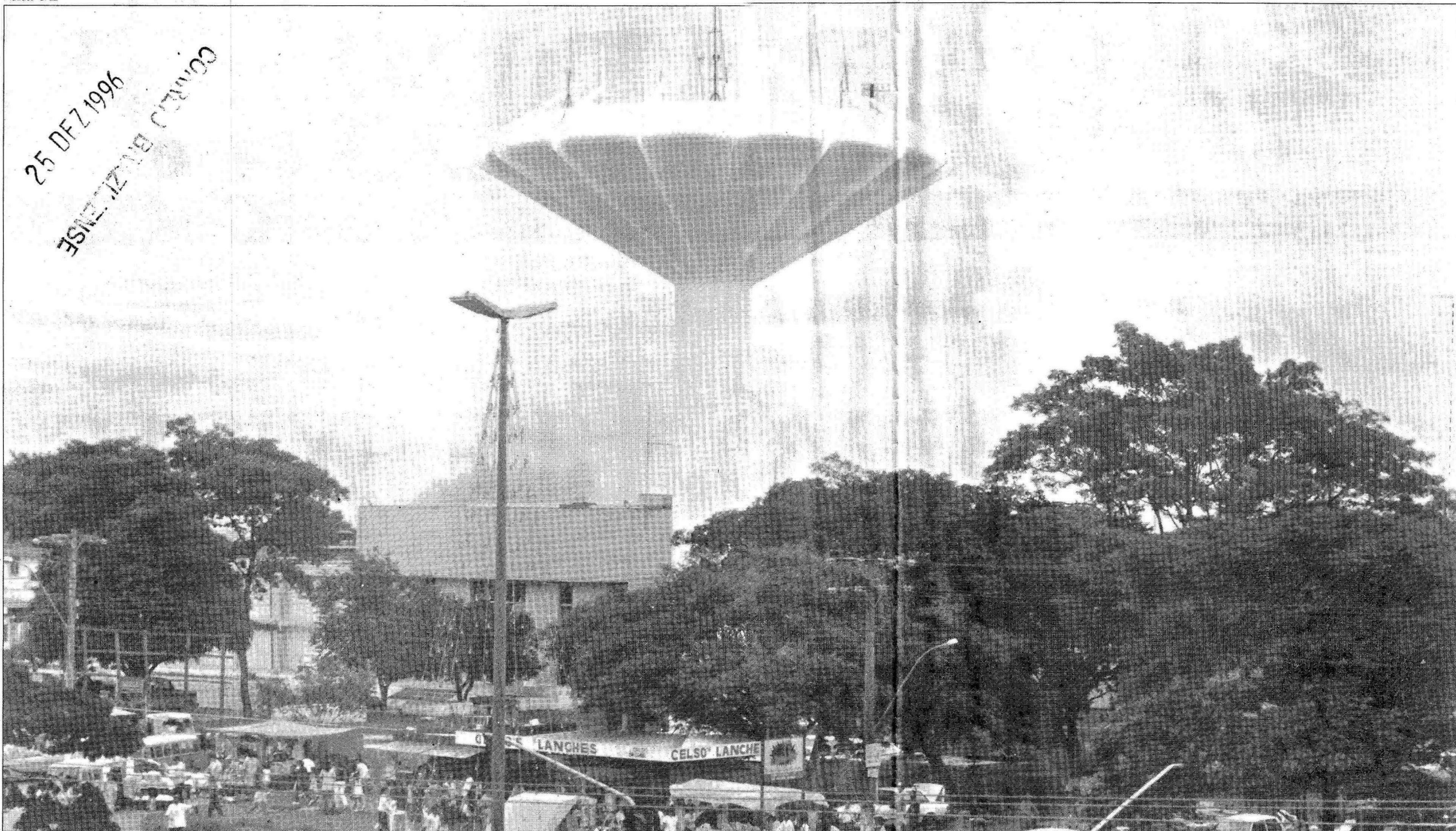
A caixa d'água está localizada no centro, mas pode ser vista de qualquer parte da Ceilândia. Construído em 1977, no formato de um cálice, o monumento é tido como uma espécie de amuleto da sorte pelos moradores da cidade
