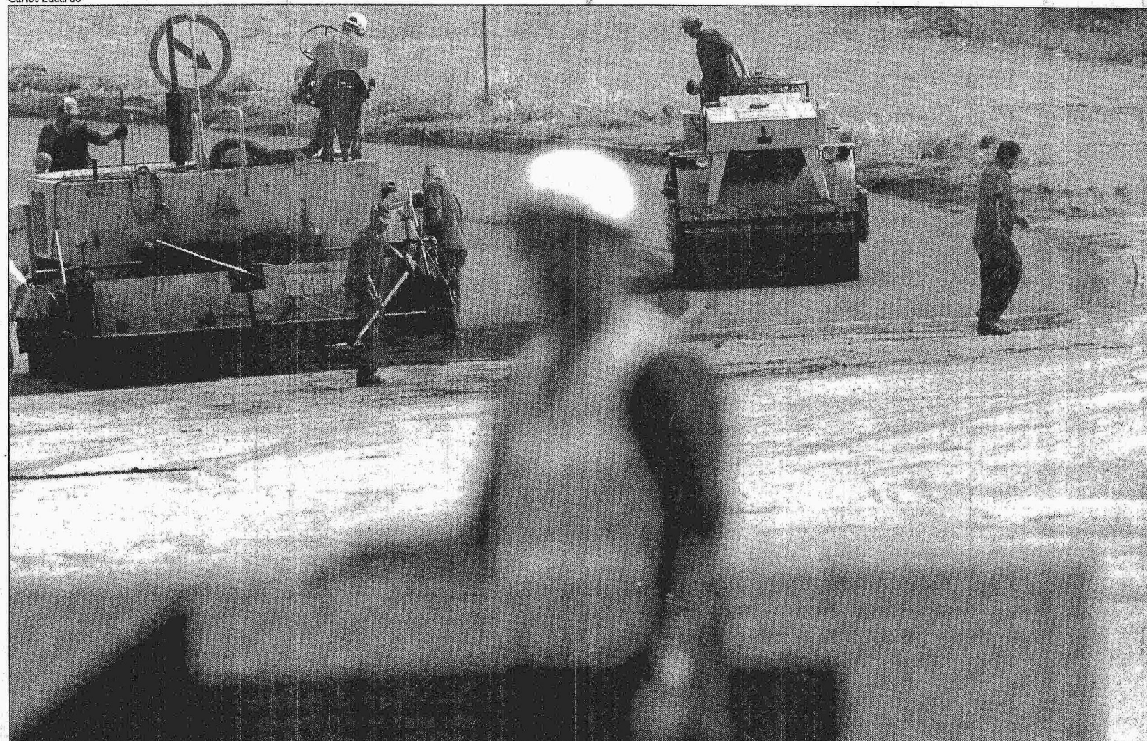
Funcionários e máquinas do governo recuperam pistas como as do Setor de Indústrias e Abastecimento (SLA), desgastadas pelo uso e pelas chuvas
