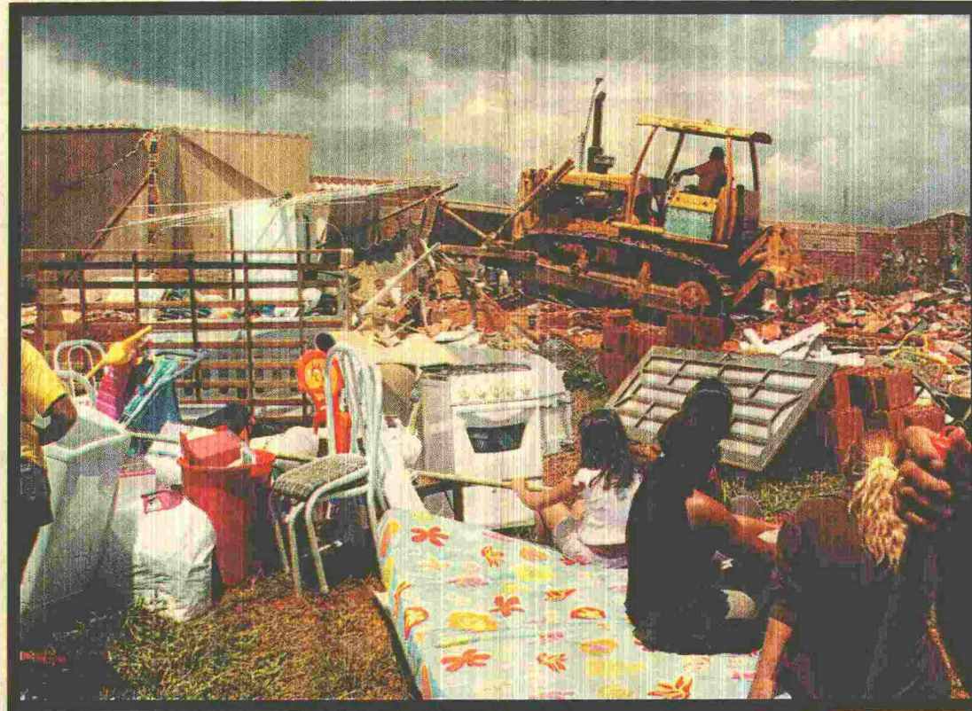
MORADORES RETIRARAM MÓVEIS E ELETRODOMÉSTICOS ANTES DA DERRUBADA: TODAS AS CASAS SERÃO DEMOLIDAS
