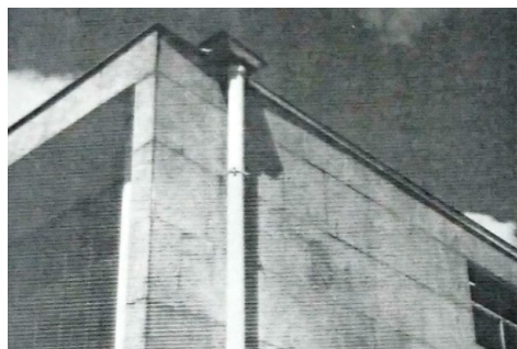
Figura 10.27 Sobrecobertura e tubos de queda eliminados em 1994-1996. 105
