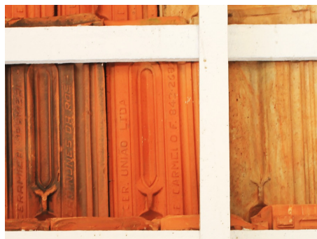
Figura 3.25 Casa da Cultura de Pires do Rio. Variações na coloração, textura e fabricante do telhamento, associadas a três momentos de fornecimento.
