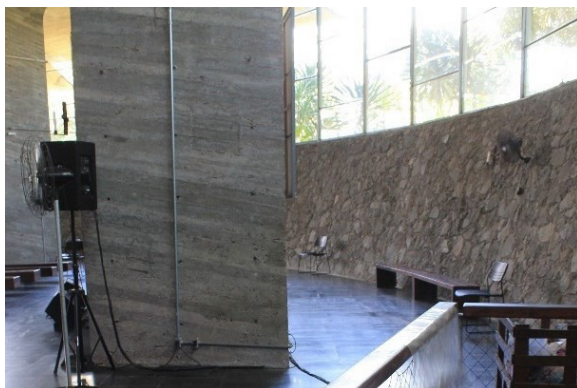
Figura 2.5 Nave. À esquerda, pilar-pétala. À direita, parede e caixilhos perimetrais.
