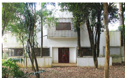
Figura 7.7 Situação atual. Fachada sul. Abertura de grandes dimensões, com esquadria e blocos de vidro, substitui janelas do pavimento superior.
