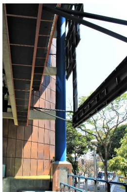
Figura 6.12 Fachada leste, dupla, vista de baixo. A camada externa se apoia na camada interna por meio de hastes de aço.
