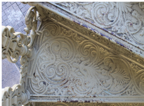
Figura 3.9 Suavização dos relevos, em função do acúmulo de repinturas nos pisos das escadas.
