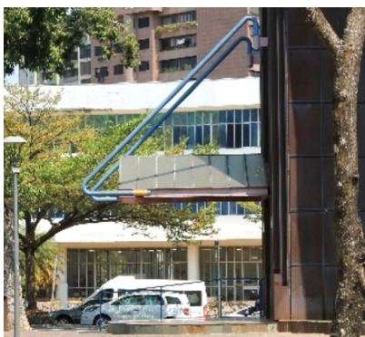
Figura 6.14 Marquise sobre o acesso, com estrutura metálica e fechamento em vidro.
