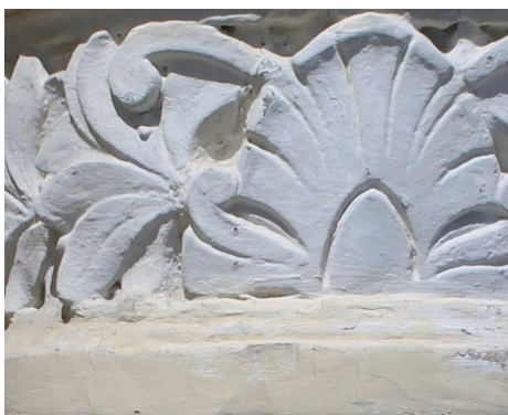
Figura 6.34 Cantina de vinhos, em Serafina Corrêa. Textura resultante das múltiplas repinturas.
