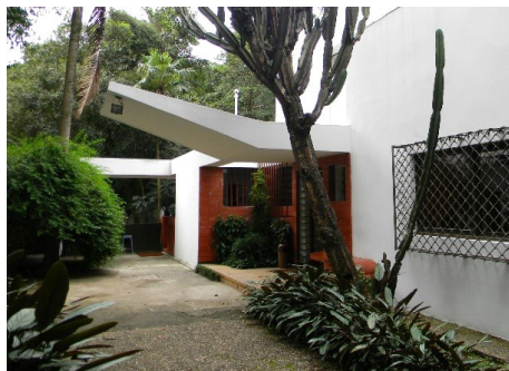
Figura 7.9 Fachada oeste (trecho). Marquise inserida na reforma de 1934-35. Ao fundo, passagem coberta para edículas.
