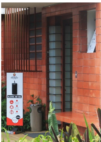
Figura 7.13 Esquadria de acesso. Volume de vidro translúcido, protegido por barras de aço.
