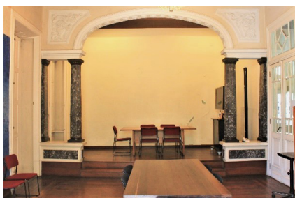
Figura 9.6 Sala de visitas. Desnível, arco de três centros e colunas de mármore, inseridos na reforma de 1928.
