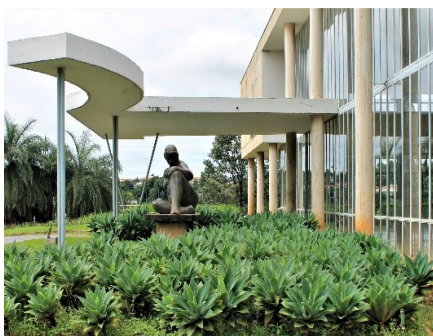
Figura i.7. Museu de Arte da Pampulha. Concluído em 1942. Belo Horizonte.
