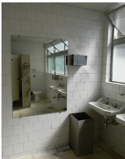
Figura 10.51 Sanitários para o público masculino. Louças e metais mantidos na reforma de 1995-1996.
