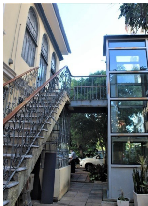
Figura 9.12 À direita, plataforma para acessibilidade (2007-2008), ligada ao patamar da escada de 1928. Sob a escada, envidraçamento dos vãos do pavimento inferior (1993-2003).
