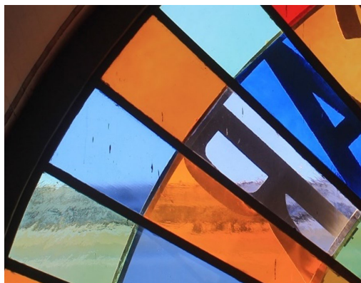
Figura 3.8 Mosaico de texturas nos vitrais, resultante do acúmulo de manutenções ao longo do tempo.
