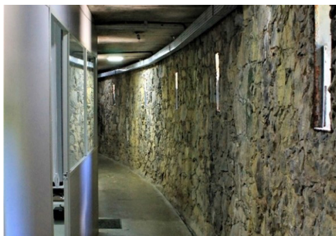
Figura 8.39 Alterações no subsolo. Instalação de eletrocalha (no alto) e divisórias (à esquerda).
