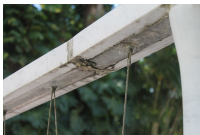
Figura 1.6. Guarda-corpo do terraço, peça partida.
