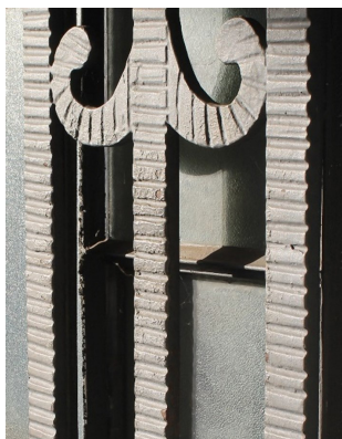
Figura 4.33 Teatro Goiânia. Textura resultante das sucessivas repinturas sobre barras de aço com seus próprios relevos.
