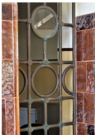
Figura 5.29 Estação Ferroviária de Goiânia. Gradil da bilheteria, em latão e vidro, com sua pátina característica.
