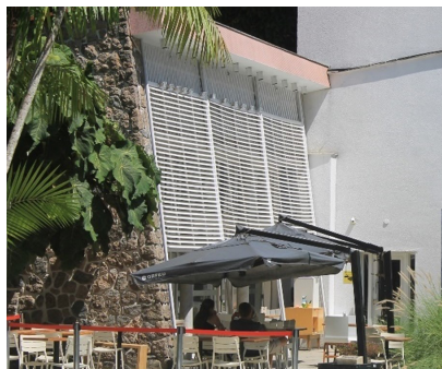
Figura 1.10. Esquadrias da sala de jantar. Observar discreta flexão dos brises horizontais.
