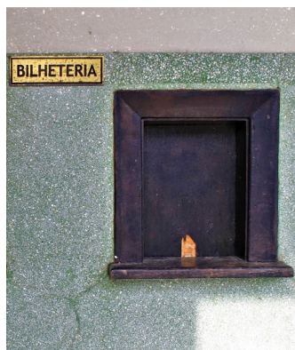
Figura 9.28 Rádio Difusora de Caruaru. Granilite com partículas de mica, em diálogo com o revestimento em pó de pedra das paredes. O envelhecimento deste material, junto à bilheteria, reforça as evocações do uso.
