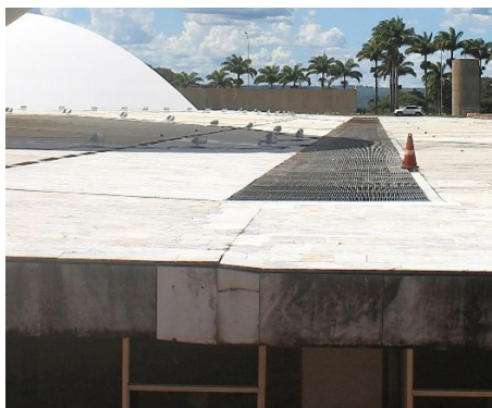
Figura 8.7 Plataforma de cobertura, 2022. À esquerda, trecho inicial, com cobertura mais inclinada. Ao centro, grelha do jardim. À direita, ampliação de 1968. Emenda visível na borda da cobertura, abaixo.
