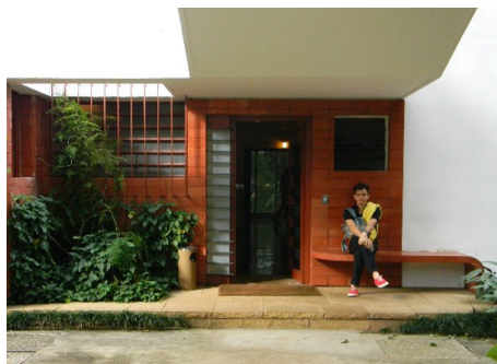
Figura 7.10 Acesso. Marquise, banco, jardim, materiais e esquadria criam espaço de chegada.
