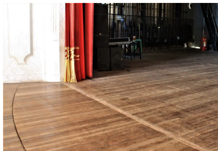
Figura 3.6 Tabuado do palco. Mesma substituído, o tabuado se apresenta com inúmeras marcas de uso.
