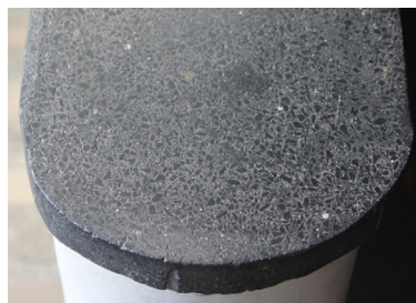
Figura 9.29 Teatro Goiânia. Corrimão interno. Revestimento integro, com pequenas lacunas e arranhões, evocando seu uso continuado.
