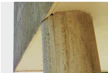
Figura 10.36 À esquerda. Granito juparaná das fachadas. Superfície plana, íntegra e arestas vivas.
