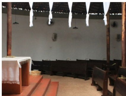
Figura 7.25 Altar mor, 2021. Nave com superfícies rebocadas e pintadas de branco.
