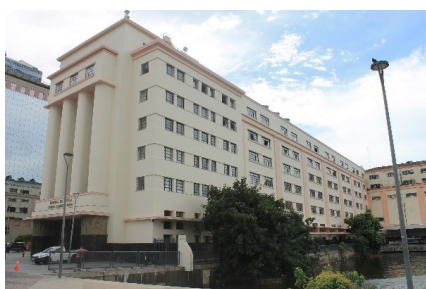
Figura 9.19 Centro Administrativo do Tribunal de Justiça do Rio de Janeiro, 2020. Observar adição de um pavimento no centro do edifício.
