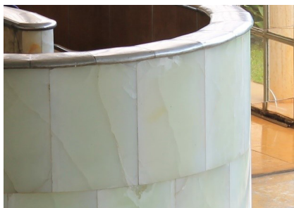
Figura 10.46 Alabastro dos parapeitos internos. Placas curvas.
