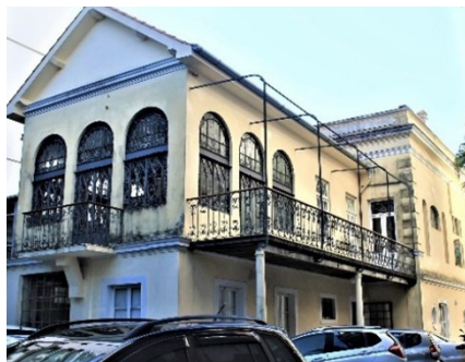
Figura 9.9 Novo volume construído em 1928.
