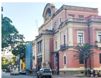
Figura 6.7 Vista atual. A distância e o volume intermediário atenuam o contraste entre os edifícios.
