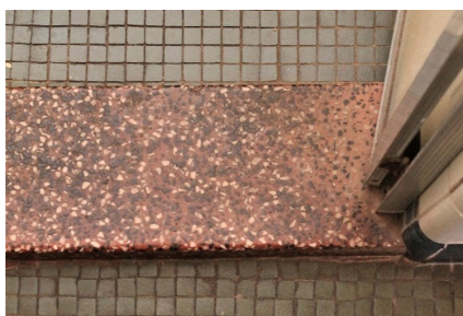
Figura 9.32 Museu Pedro Ludovico. Soleira de banheiro. Diferentes graus de exposição geraram abrasão da matriz cimentícia na parte esquerda da peça.
