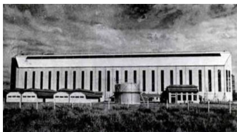
Figura 4.1 Aeroporto Bartolomeu de Gusmão, com suas instalações técnicas, conforme retratado na publicação Aviação Civil , de 1939. 11
