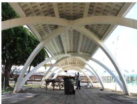
Figura 4.26 Passadiço de embarque, com estrutura em concreto armado.
