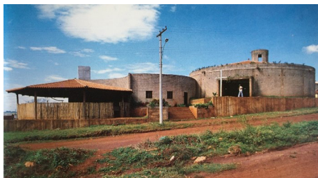
Figura 7.24 Vista geral, a partir do norte, em 1982. Da esquerda para a direita: barracão, claustro e nave. 48
