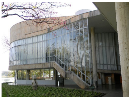
Figura 10.8 Volumes de serviço. Volumes principais e topos de lajes revestidos em pedra, em relação com fechamentos em azulejos e alvenaria pintada de branco.
