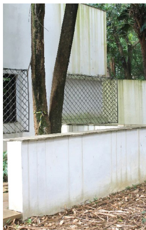
Figura 7.8 Situação atual. Fachada sul. Janela sudeste, fechada na reforma de 1934-35. O arquiteto manteve a simetria existente, usando um baixo-relevo e um gradil semelhante aos demais.
