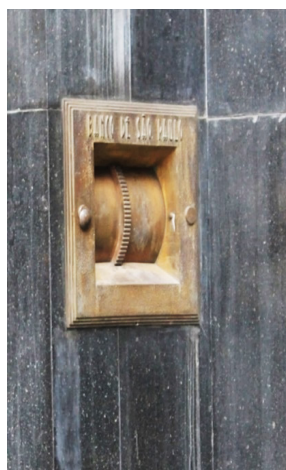
Figura 4.24 Antigo Banco de São Paulo. Reminiscências do uso. Dispositivo para depósitos noturnos, instalado na fachada.
