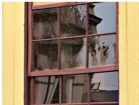
Figura 3.23 Casa da Neri. Variação de textura entre vidros irregulares, mais antigos, e vidros perfeitamente planos, substituídos posteriormente.
