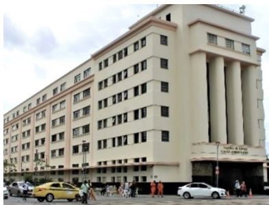
Figura 5.25 Centro Administrativo do TJRJ. Aspecto geral, mostrando esquadrias laterais.
