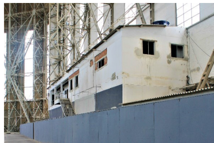
Figura 9.27 Observar impacto da nova adição no interior, com dois pavimentos.
