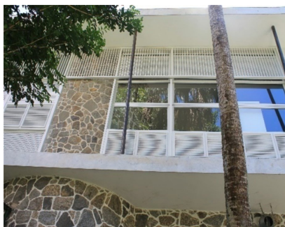
Figura 1.14. Alvenaria de pedra, fachada sudeste. Volume da escada, juntas limpas e pintadas.
