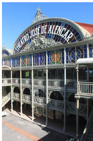
Figura 3.2 Teatro José de Alencar. Pátio interno e fachada do volume da plateia.
