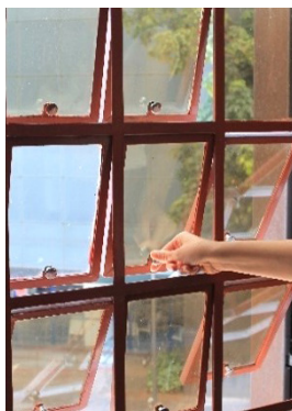
Figura 6.9 Esquadrias do volume que contém as escadarias. Rótulas ou janelas maxim air em miniatura.
