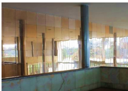
Figura 10.33 Parede de espelhos rosados/bronze. Variações no fornecimento ao longo das ações de manutenção.
