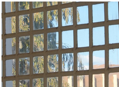
Figura 3.22 Estação Ferroviária de Goiânia. Variações de textura entre vidros irregulares e vidros perfeitamente planos, correspondentes a diferentes momentos de fornecimento.
