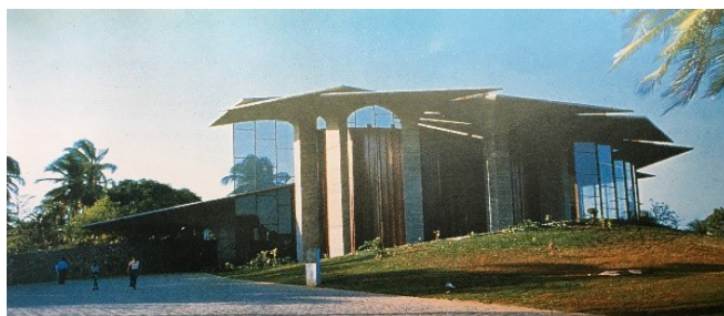
Figura 2.1 Igreja da Ascensão do Senhor. Vista externa, não datada. 3
