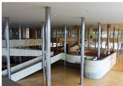
Figura 10.7 Salão inferior e galeria. Independência entre apoios, pisos e divisões internas.
