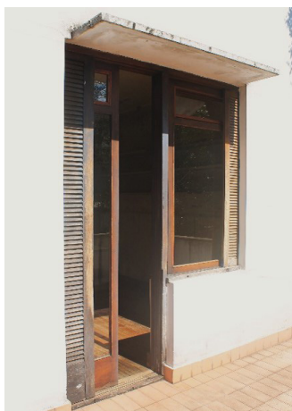
Figura 7.14 Esquadria do quarto sudoeste. Combinação de marquise, porta e janela, folhas de correr e de tomar, venezianas e vidro.
