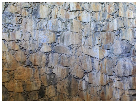
Figura 2.7 Capela do Santíssimo Sacramento. Alvenaria de pedra com manchas em tons de cinza e ocre.
