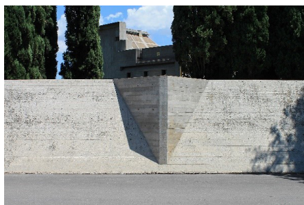
Figuras 2.12 e 2.13. Carlo Scarpa, Mausoléu Brion, S. Vito. Concreto projetado para envelhecer, restaurado preservando parte do envelhecimento.
