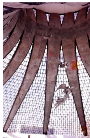
Figura 8.47 Interior da Catedral, com concreto aparente e vidros lisos, c. 1970. 98
