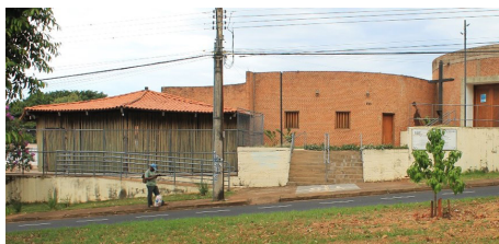
Figura 7.26 Vista a partir do norte, 2021. Observar instalação de rampas e guarda-corpos.
