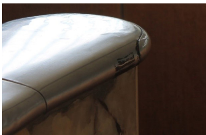
Figura 10.44 Peitoril da escada da tribuna. Encaixes entre as folhas de aço inoxidável.
