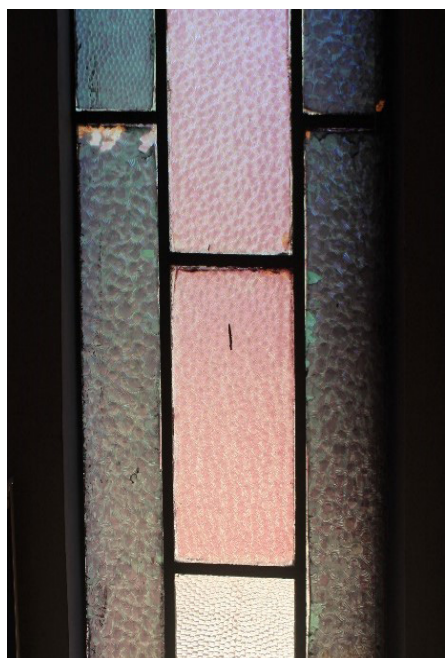
Figura 3.17 Museu Zoroastro Artiaga. Vitral. Variações de textura e coloração correspondentes a diferentes momentos de fornecimento.
