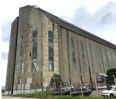
Figura 4.4 Vista do Hangar de Santa Cruz a partir do sudeste, permitindo observar o volume construído, sua superfície e sua fenestração.
