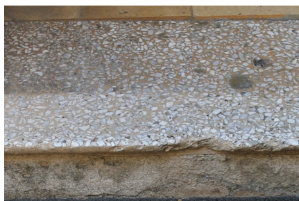
Figura 9.30 Palacete Argentina, em Porto Alegre. Degrau em granilite exposto aos agentes atmosféricos. Lacunas de médio porte.
