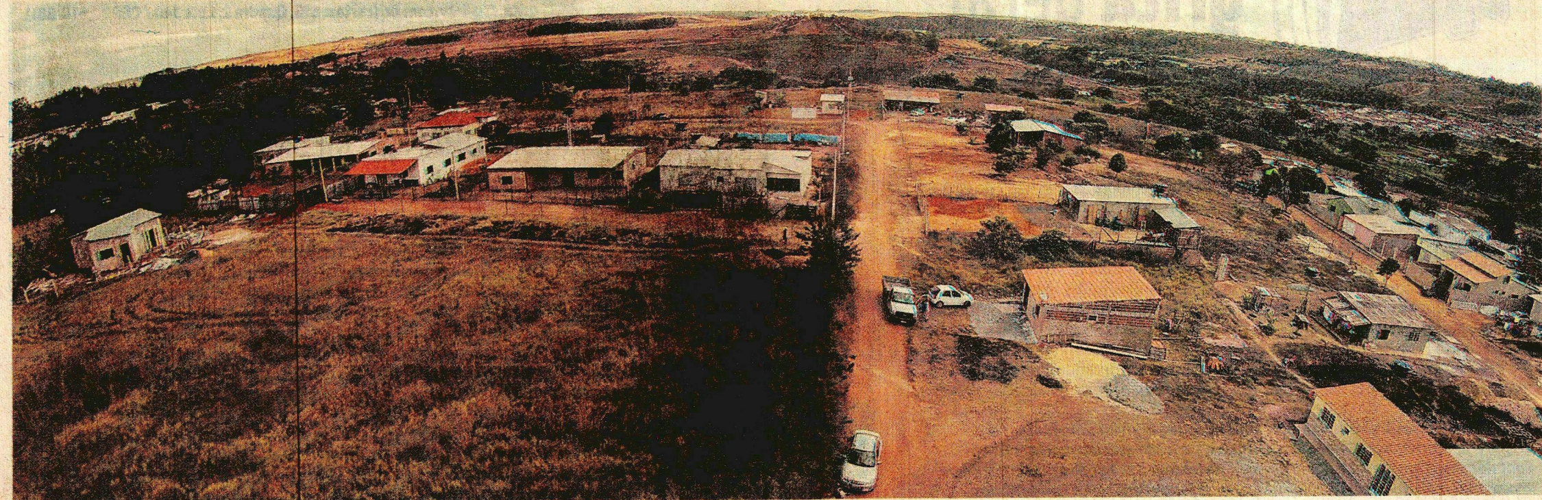
Do alto, é possível ter uma ideia mais clara dos danos causados: moradores da região reclamam da falta de fiscalização e do avanço galopante das construções
