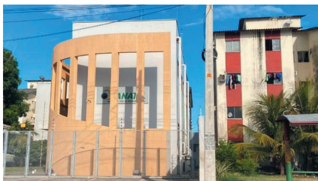
Figura 2 – Prédio da ANATEL, bairro Beirilândia, 2024.
