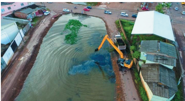
Figura 12 – Drenagem do Canal do Beírol. Fonte: Acervo Tiago Pedrada, 2024.
