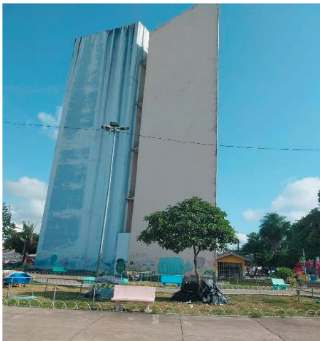
Figura 6 – Caixa d'água do Buritizal, elemento topo perceptivo.
