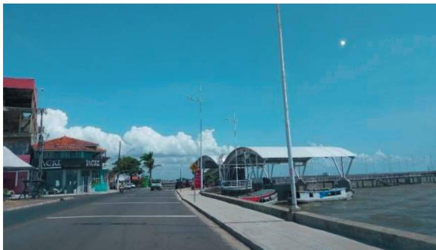
Figura 6 – Rampa do Açaí, bairro Santa Inês, Macapá – AP Fonte: Autores, 2024.
