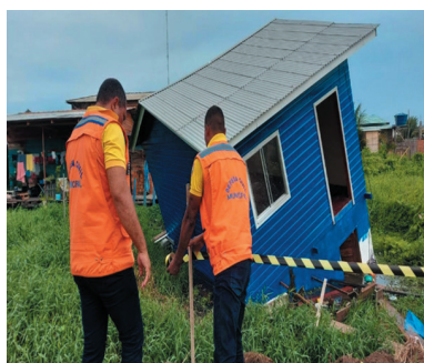
Figura 3 – Agentes da prefeitura são chamados para remover casa no bairro do Araxá. Fonte: Malcher, 2023.
