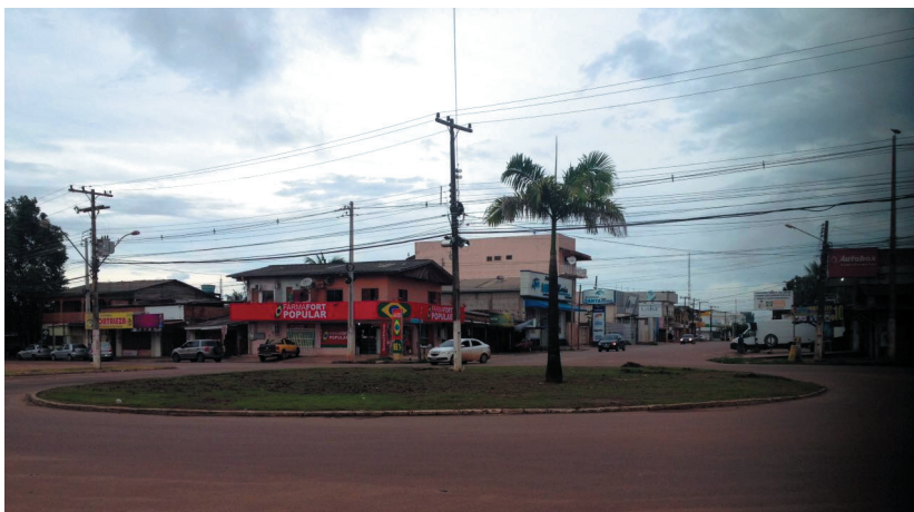
Figura 3 – Rotatória no Buritizal, tipologias variadas de edificações.
