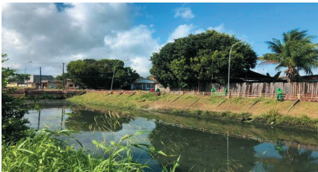
Figura 11 – Serviços de limpeza ao redor do Canal. Fonte: Acervo Tiago Pedrada, 2024.
