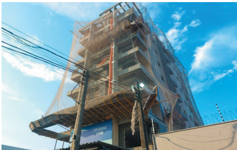
Figura 13 – Verticalização média – obra em construção.
