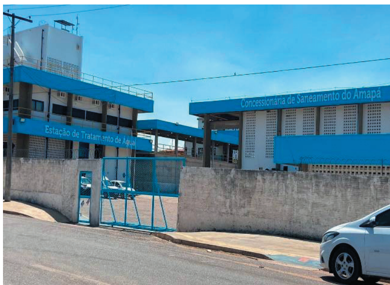
Figura 4 – Atual Estação de Tratamento de Água (ETA).
