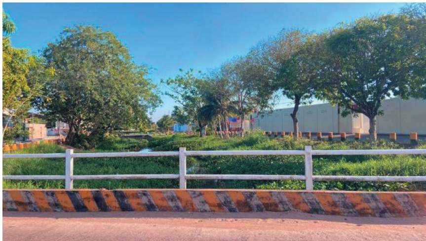
Figura 9 – Trecho do Canal do Beiol. Fonte: Acervo Tiago Pedrada, 2024.
