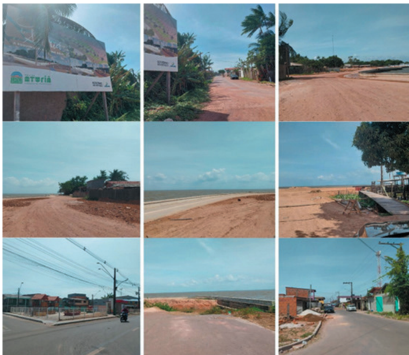
Figura 4 – Mosaico de fotos da construção do Projeto Orla no bairro de Araxá.
