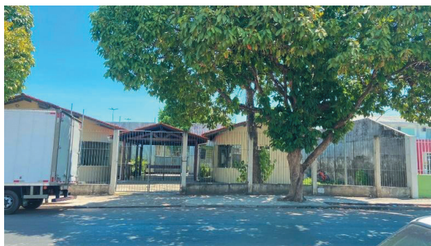
Figura 3 – Prédio do CESEIN.
