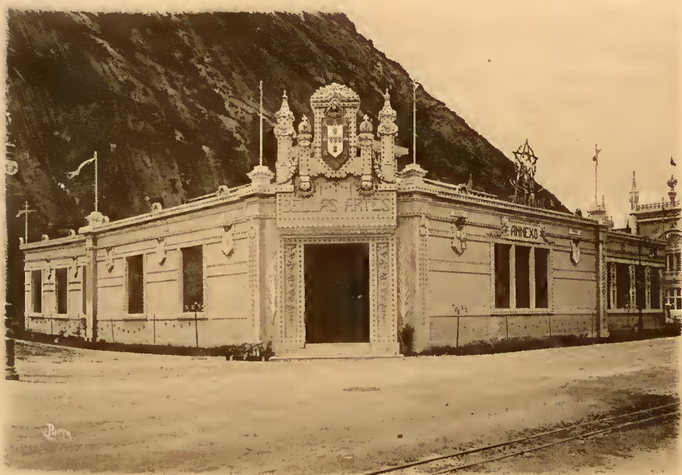
Annexo do Pavilhão Portugal
