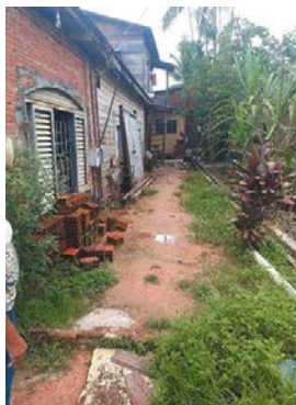
Figura 49: Vista lateral da edificação da casa de Dona Carmem e Casp em 2019.
