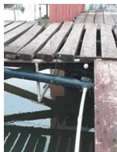
Figuras 24 a 27: Situação existente das passarelas e redes instaladas para abastecimento de água na área de ressaca dos Congós. Projeto #lavatoriosnaponte 2020. Acervo Atau-Unifap, 2020.
