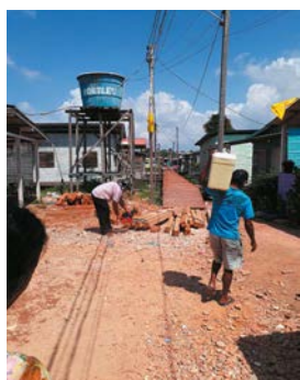
Figura 8: Início da passarela em obras de reforma. Foto: Melissa Matsunaga, 2018.
