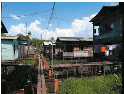
Figura 10: Vista geral das casas em área de ressaca no bairro Zerão.
