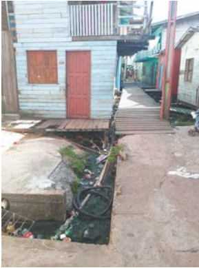
Figura 38: Esgoto a céu aberto no início da “Área da Caesinha”. Foto: Melissa Matsunaga, 2018.
