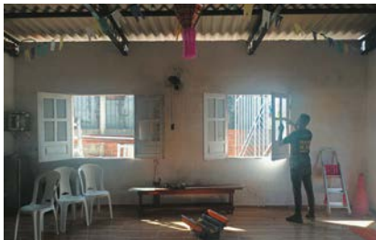
Figura 59: Vidraceiro realiza manutenção na esquadria do Casp após reformas. Foto: Melissa Matsunaga, 2024.
