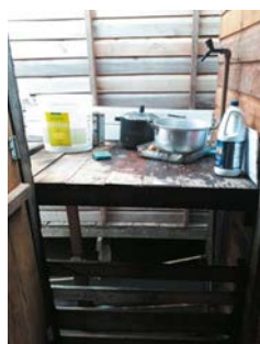
Figura 31: Jirau de madeira sem cobertura.
