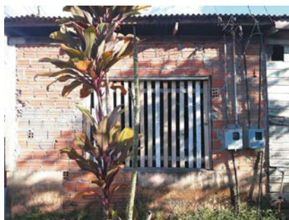
Figura 45: Esquadria e parede lateral externa do Casp sem reboco. Detalhe das instalações elétricas. Acervo Atau-Unifap.
